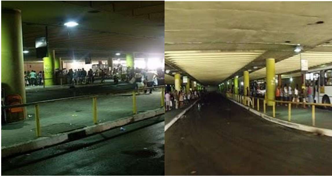
Figura 8 Foto subestação da Lapa.
