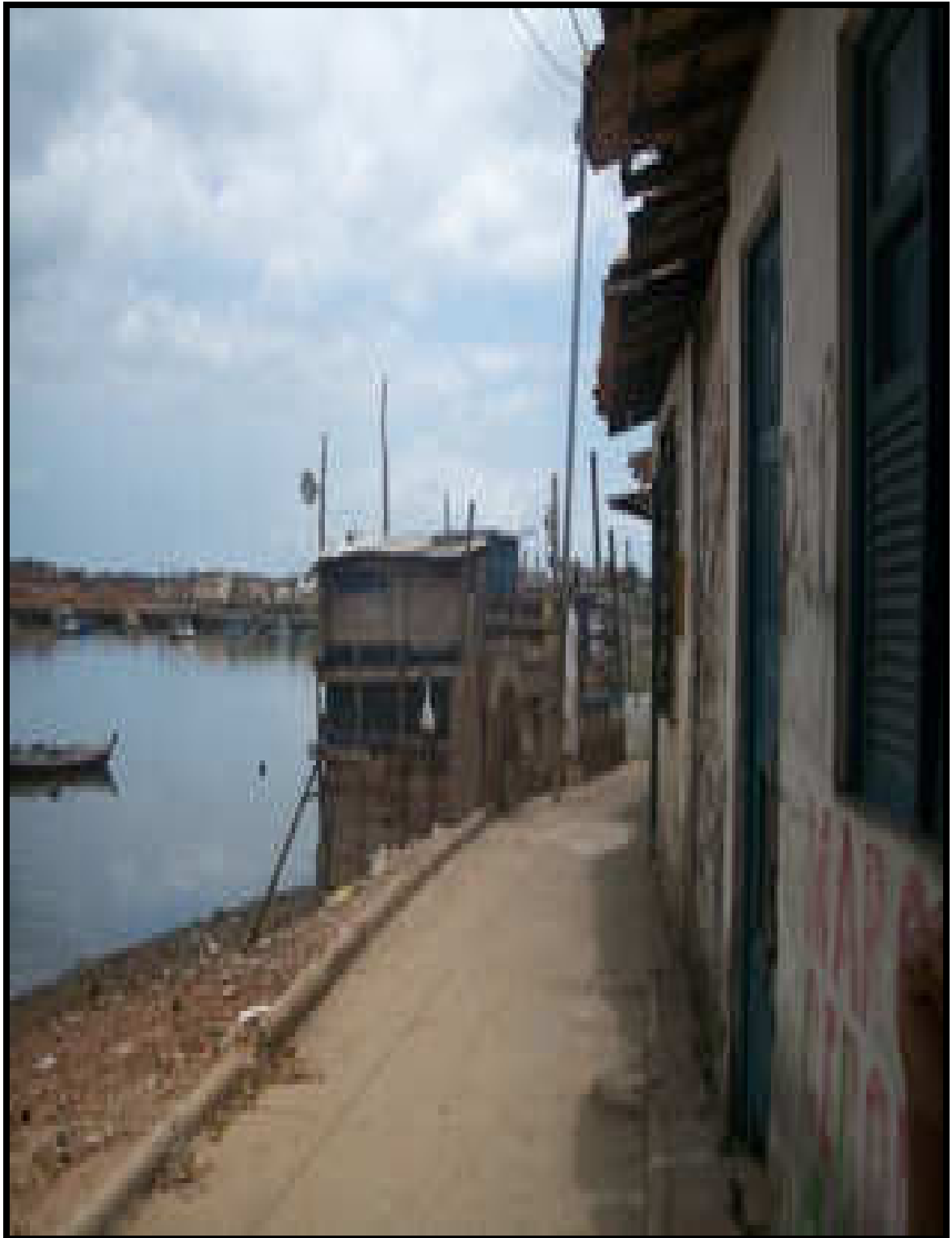
Figura 6: Infraestrutura nos Distritos (3) Fonte: Tânia Bispo, 2009.
