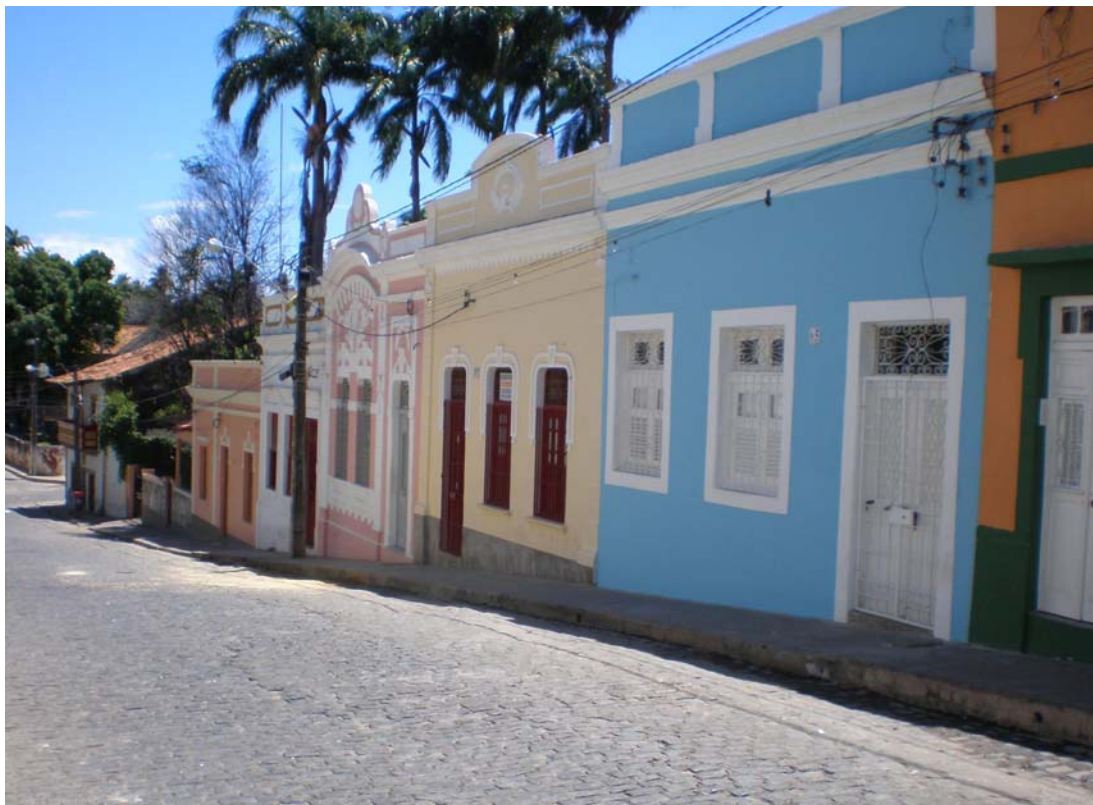
Fotografia 4 – Rua Vinte e Sete de Janeiro 12
