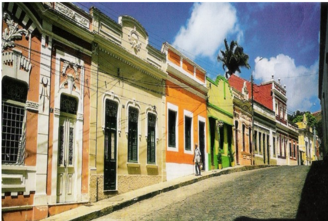
Fotografia 23 – Rua Vinte e Sete de Janeiro 79
