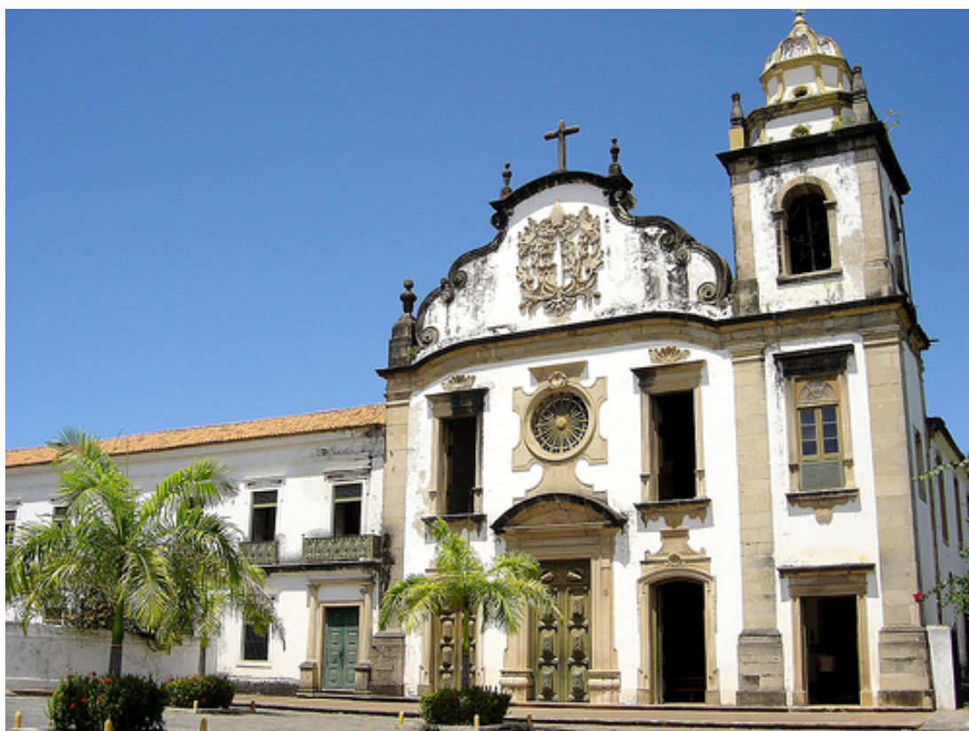
Fotografia 77 – Fachada principal do Mosteiro de São Bento de Olinda 23
