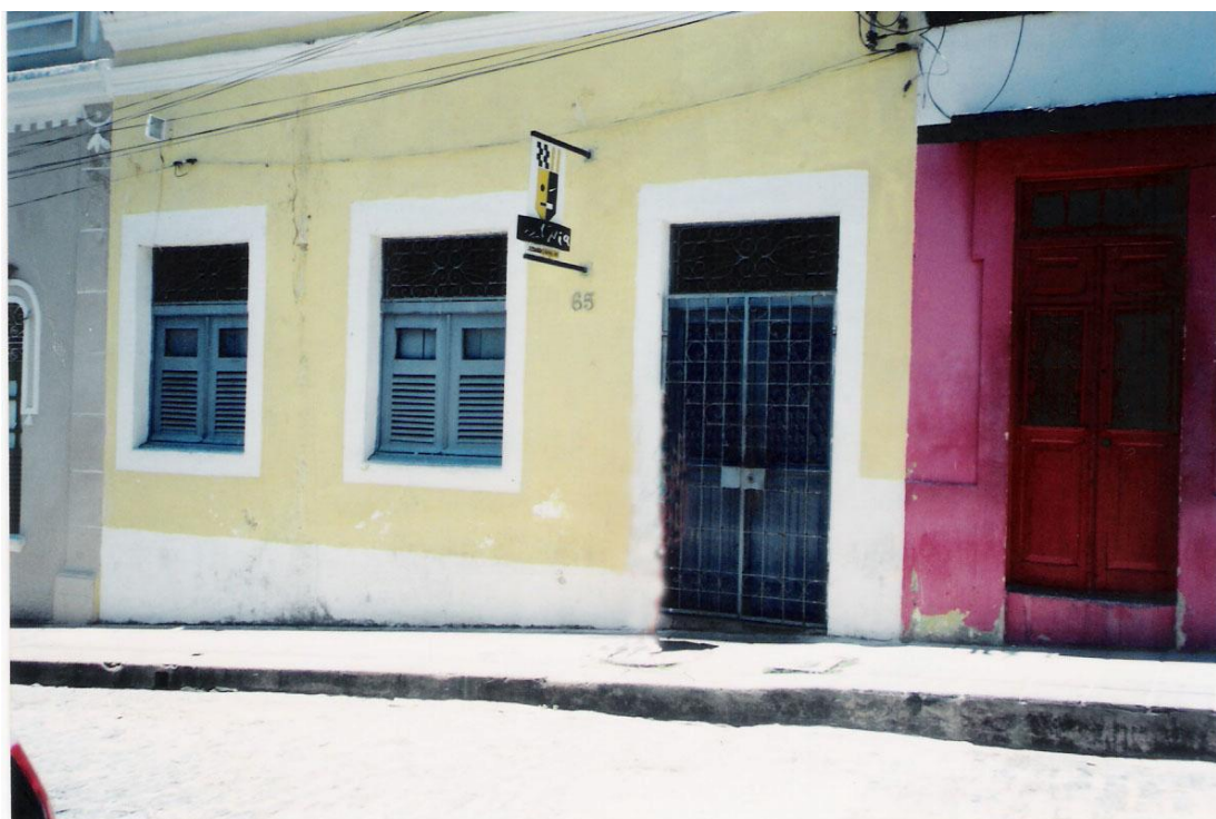
Fotografia 68 – Olinda. Casa nº. 65, da Rua Vinte e Sete de Janeiro 68
