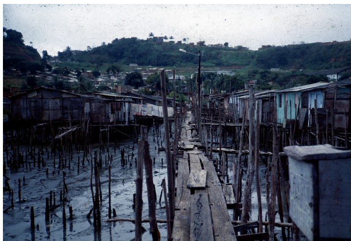
Figura 119 - Ponte com pontas de madeira de construções removidas em Novos Alagados. Foto Vera Lazarotto.
