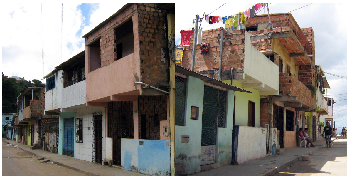
Figuras 92 e 93 - Avanços sobre a calçada na Rua Chile, Novos Alagados. Todos os entrevistados afirmaram que nesta área era "permitido" o avanço sobre a calçada. Foto do autor.
