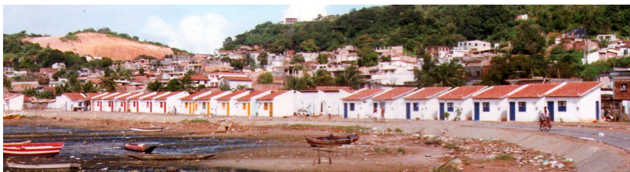
Figura 157 - Novas unidades implantadas ao longo da Avenida Beira Mar. Foto Vera Lazarotto.
