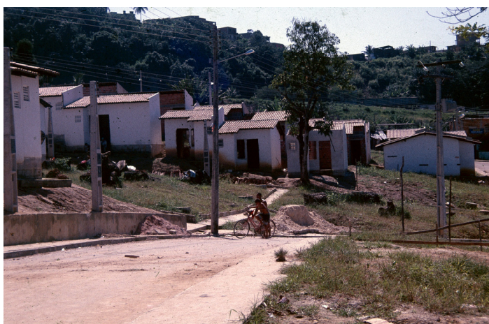
Figura 31 - Conjunto Araçás I em fase final de construção. Foto Vera Lazarotto.
