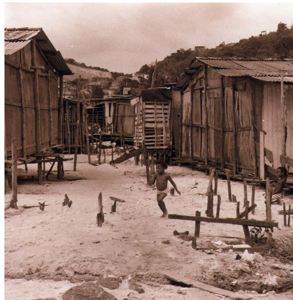
Figura 79 - Aterramento das palafitas, em 1997. Foto Vera Lazarotto.
