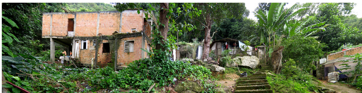
Figura 104 - Casas em meio à vegetação no trecho superior do Morro da Babilônia. Foto do autor.
