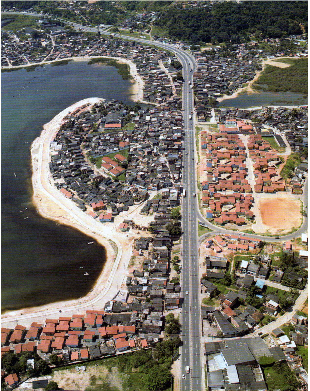
Figura 25 - Vista Parcial de Novos Alagados: Av. Suburbana, Nova Primavera, Tóster e Boiadeiro. Fonte: Sedur (2006).
