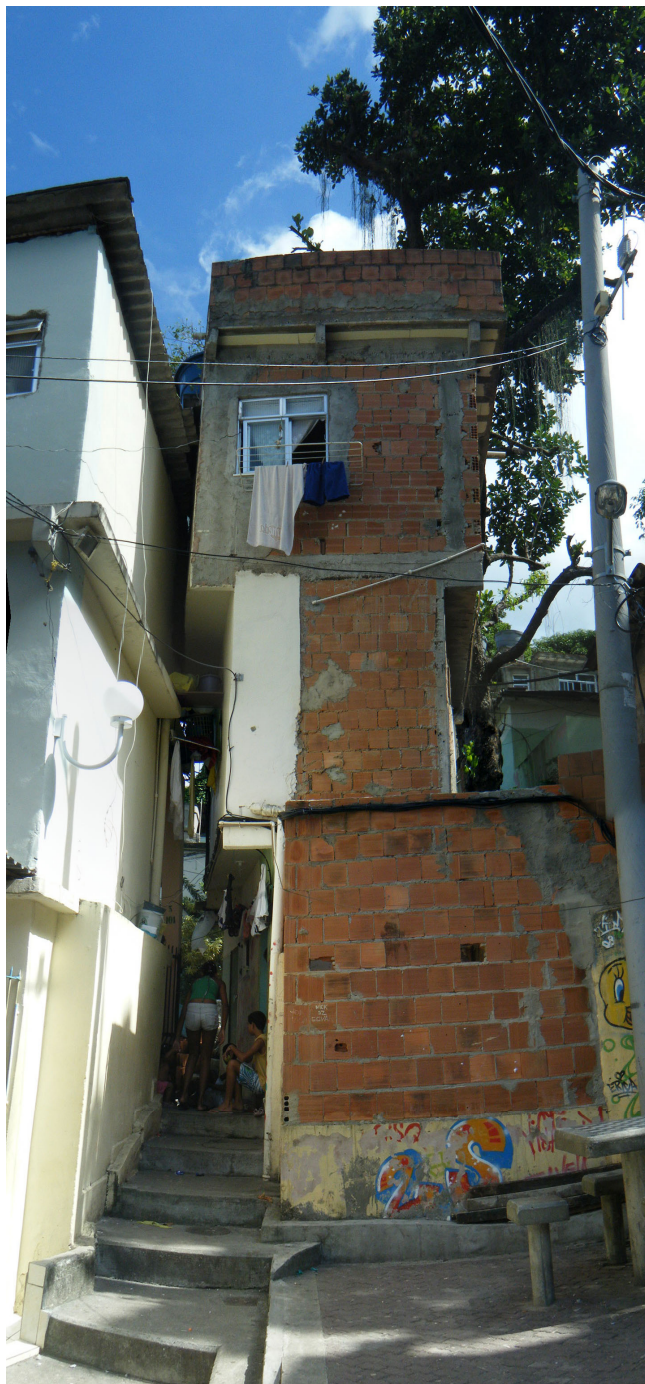
Figura 84 - Construção, e adaptação, no Santa Marta. Foto do autor.
