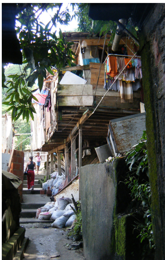
Figura 88 - Manutenção da funcionalidade, apesar da precariedade construtiva. Foto do autor.
