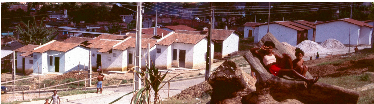
Figura 154 - Módulos habitacionais construídos em Araçás I Foto Vera Lazarotto.
