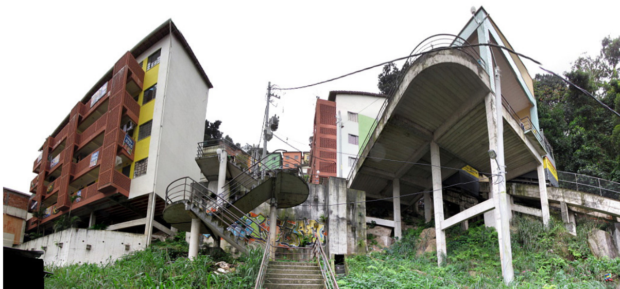
Figura 147 - O "Jambalaia" e as estruturas de acessibilidade e da base da Estação 3. Foto do autor.
