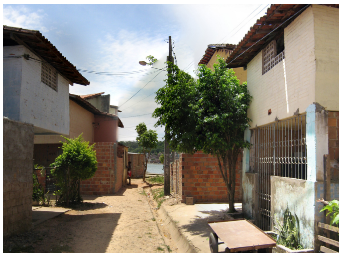
Figura 167 - Estreitamentos no sentido transversal. Foto do autor.
