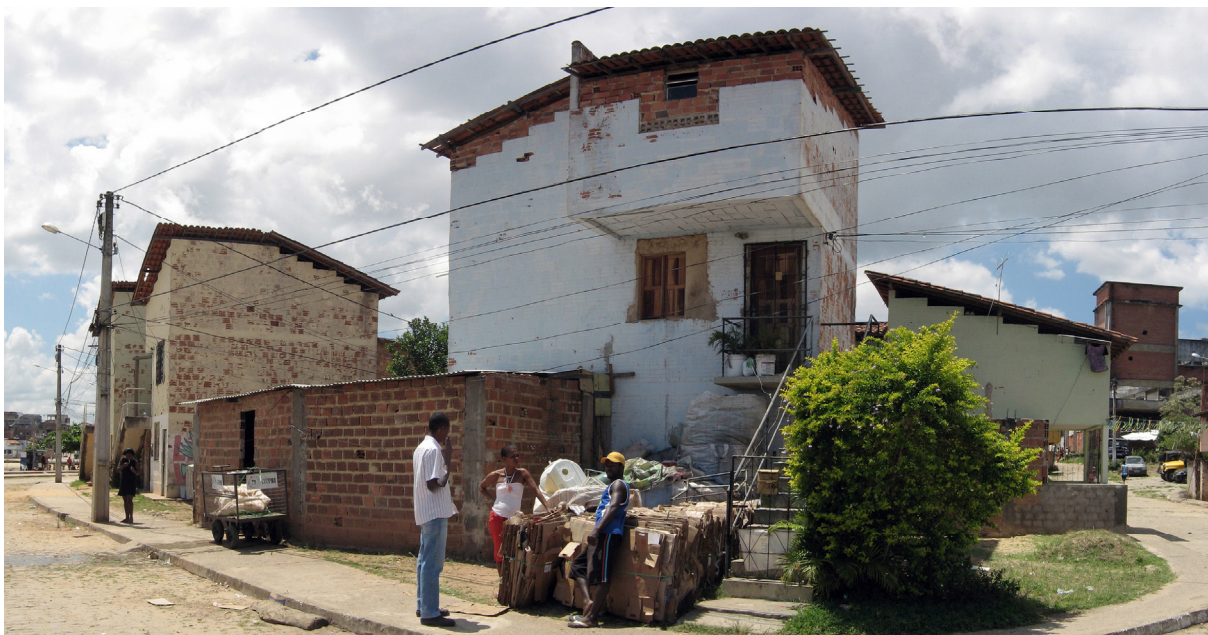
Figura 164 - Complementação do pavimento e ocupação dos espaços remanescentes no conjunto da Tóster. Foto do autor.
