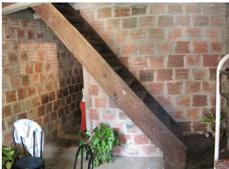
Figura 126 - Escada implementada pela Conder em Novos Alagados. (Casa de Dona Denise, no Boiadeiro).
