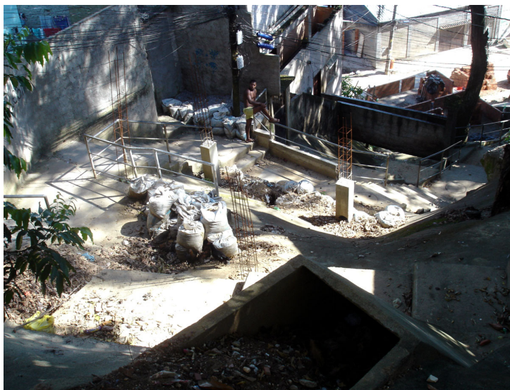
Figura 83 - Construção em execução sobre espaço coletivo. Foto do autor.
