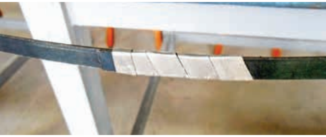
Figura 45. A fita de aço é presa em formato circular (autor, 2013).
