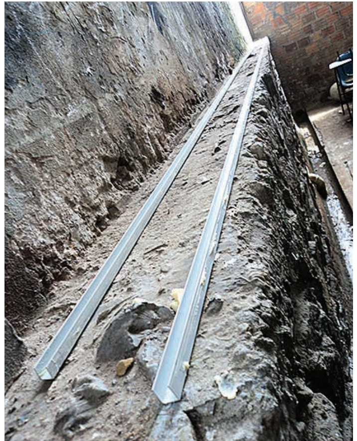
Figura 16. Esquadrias de alumínio servem de molde para a confecção das fitas de resina
