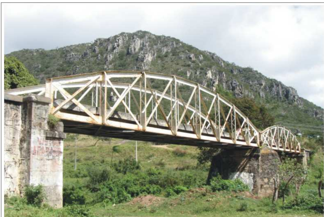
Figura 34: pontilhão de 50 metros sobre o rio Itapicurú-mirim na entrada de Jacobina. Trata-se do mesmo da figura 9 no capítulo II. Vê-se o piso em concreto feito para permitir o tráfego de automóveis. Fonte: fotografia do autor. Jacobina, junho de 2009.
