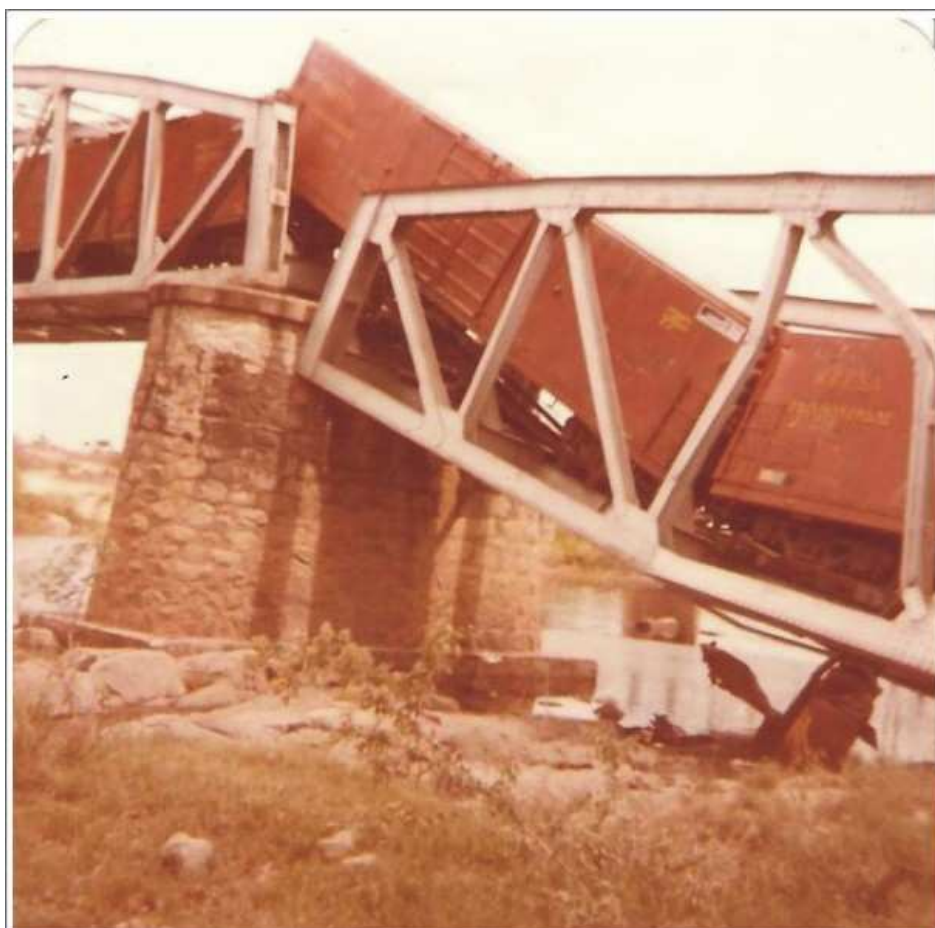
Figura 37: acidente que derrubou uma das seções da grande ponte sobre o rio Paraguassú. Iaçú, 1983. A cidade perdeu a ferrovia e ganhou um inusitado cartão postal. Fonte: Projeto Iaçú Cultural.
