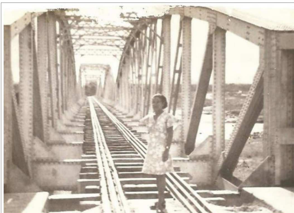
Figura 10: pontilhão de 200 metros sobre o rio Paraguassú em Iaçu. Foto tomada no sentido de quem segue para Itaberaba.
