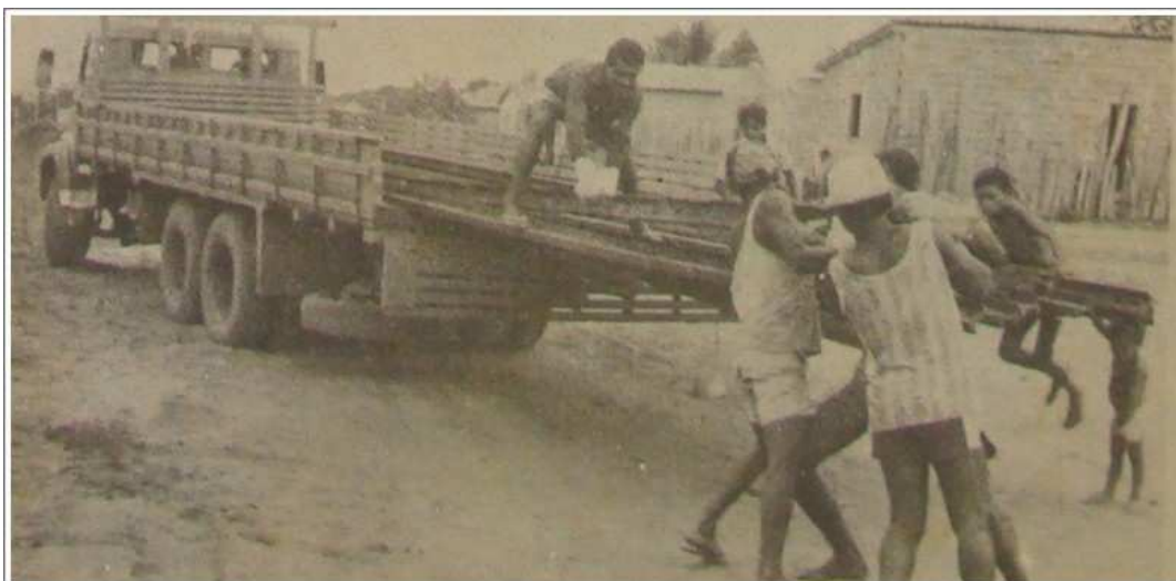
Figura 35: remoção dos trilhos da ferrovia da Grota a mando da Prefeitura Municipal de Itaberaba, maio de 1989. Fonte: reprodução de O Paraguassú , 15 mai. 1989, p. 3.
