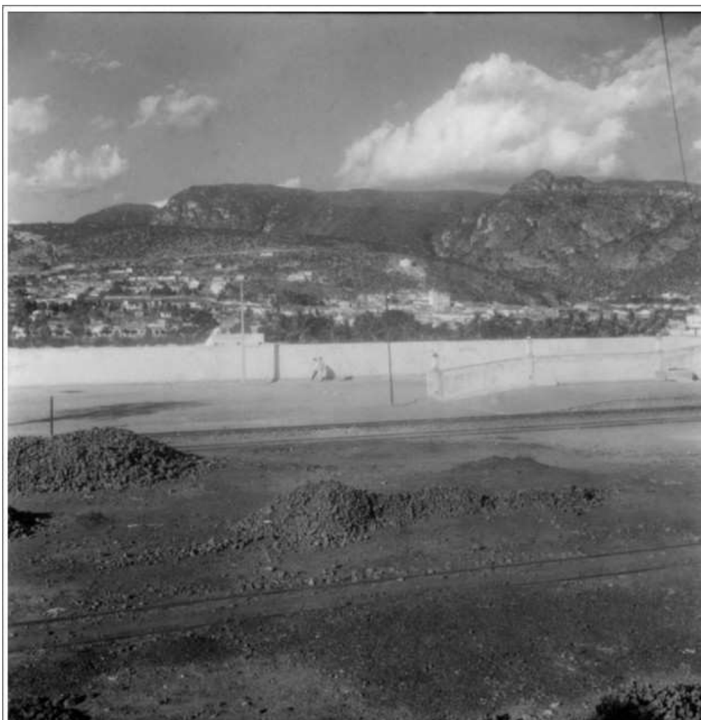
Figura 26: minério de manganês depositado no pátio da estação de Jacobina, início dos anos 60. Nota-se a falta de estrutura para embarque de minerais, situação comum a todas as estações da ferrovia da Grota.
