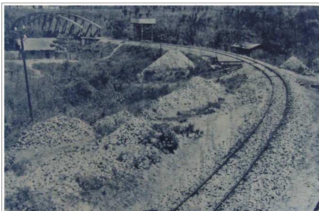
Figura 19: trecho da ferrovia nas imediações de Barra de Mundo Novo sendo empedrado. Fonte: reprodução VFFLB, 1942.
