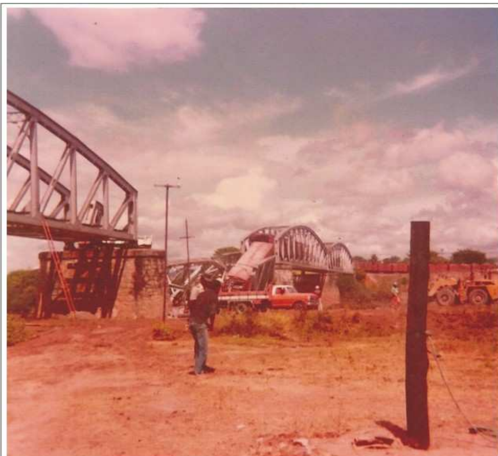
Figura 38: construção de desvio e ponte provisória para resgatar os vagões presos na outra margem do rio após o acidente de 1983. Iaçú, março de 1984. Fonte: Projeto Iaçú Cultural
