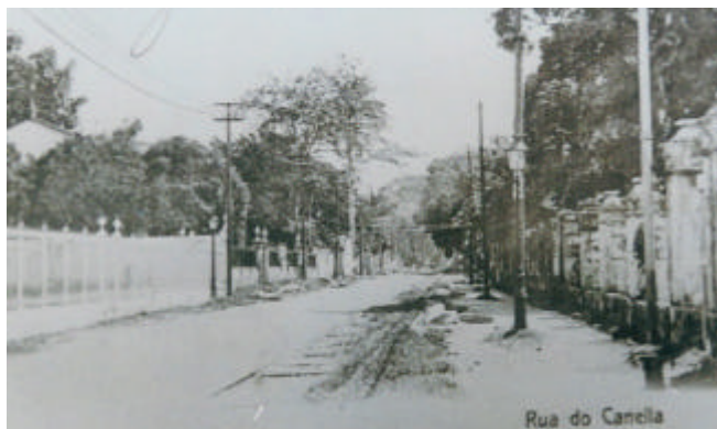
Fig. 8 - Trecho da Rua do Canela, fotografado em 1915. Fonte: CEAB - Centro de Estudos de Arquitetura na Bahia FAUFBa.
