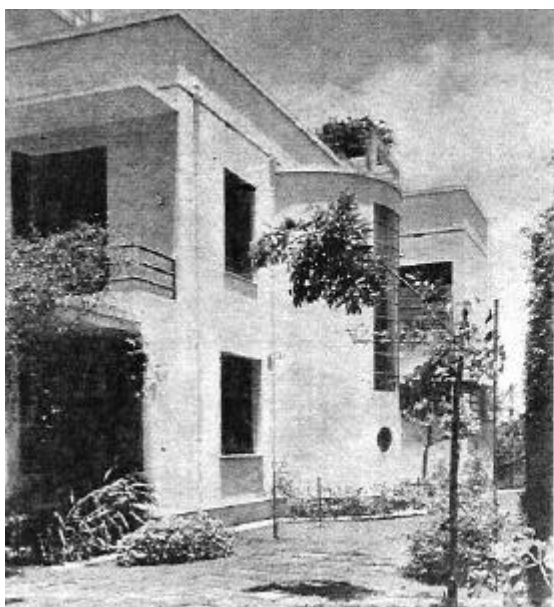
Fig.16 - Fachada lateral ilustrando a articulação dos volumes ortogonais e curvos.
