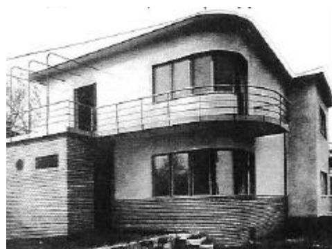
Fig.11 - Casa na Hungria, Budapeste Fonte: DOCOMOMO (1996).
