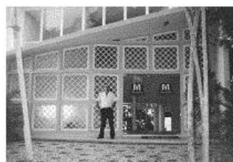
Fig. 63 - Articulação da garagem com o corpo da casa
