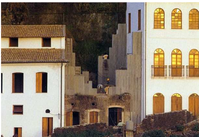
Fig.53: Sobrados, ruína e contrafortes
