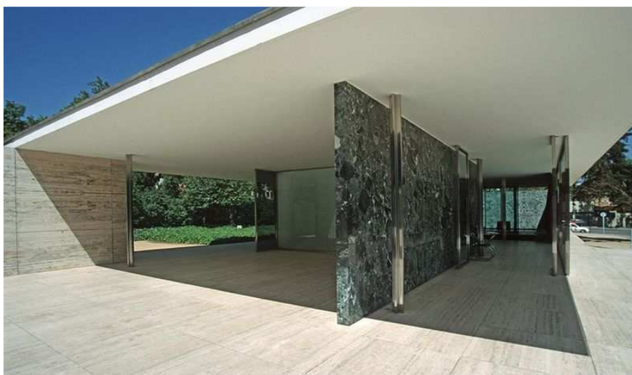
Fig.15: O Pavilhão de Barcelona reconstruído
