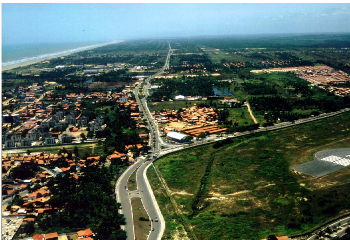
Figura 118: Vista panorâmica da Rodovia dos Náufragos (continuação das avenidas Hildete Falcão e Melício Machado).
