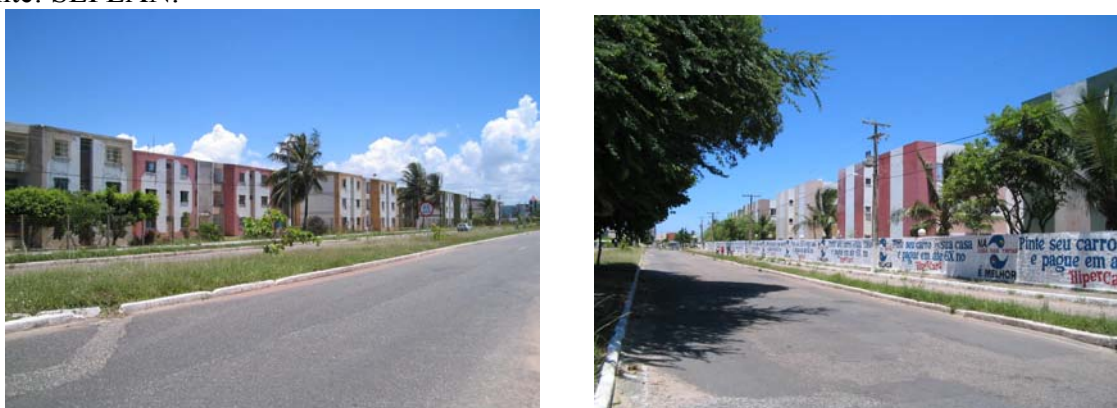
Figura 97: Prédios baixos no bairro Coroa do Meio (invadidos por sem-teto). Fonte: da autora (2003).
