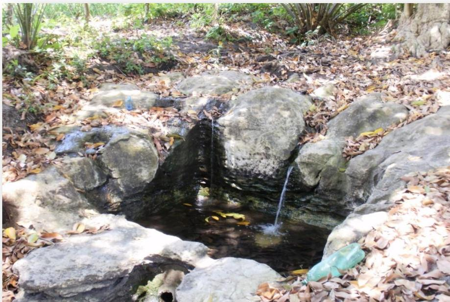
Fonte: Acervo do autor, (dezembro de 2010). Fotografia do tanque escavado na rocha calcária. A água subterrânea existente nos interstícios da camada superior ao calcário, de constituição arenítica (Formação Barreiras), ressurge na forma de fonte na lateral do tanque. Possivelmente essa ressurgência corresponde àquela que na segunda metade do século XIX chamava-se Cacimba do Povo ou “Fonte do Riacho, aberta em 1830, para servir aos moradores de Trincheiras...” (NÓBREGA, 1974, p.29).
