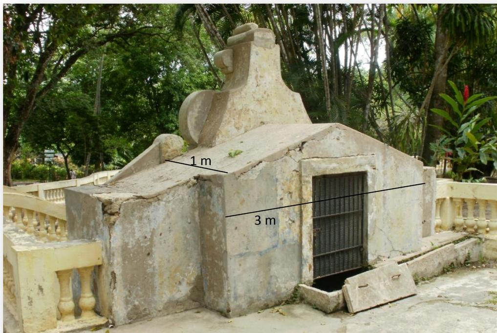
Fonte: Acervo do autor, (dezembro de 2009). Parte posterior da bica de Tambiá onde pode ser observado o tanque de acumulação de água com portão de acesso ao mesmo. As dimensões do tanque são: 3m de largura, 1m de espessura e aproximadamente 1,3m de profundidade, totalizando um acúmulo de cerca de  $4\text{m}^3$  de água.
