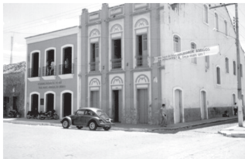
Figura 3 b- O sobrado é transformado em câmara dos vereadores, sendo sua fachada recomposta. A busca pela 'eterna imagem do passado'. Fonte: arquivo IPHAN.
