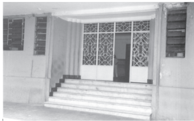
Fig. 26 - Hospital Santa Terezinha, Construtora Emílio Odebrecht e Cia, 1937-42 (acesso principal).
