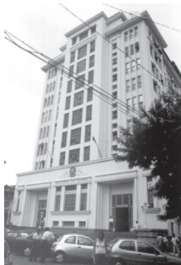
Fig. 18 - Prédio do Ministério da Fazenda, Construtora Norberto Odebrecht, 1949.
