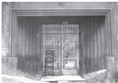
Fig. 28 - Ed. Santa Clara, Rua Chile, 3 (acesso lateral).
