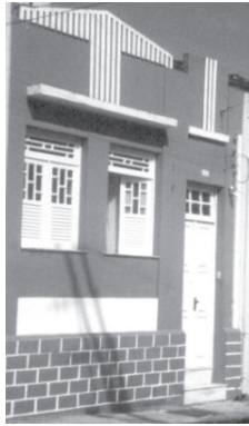
Fig. 24 - Casa à Rua do Baluarte, Sto. Antonio Além do Carmo.
