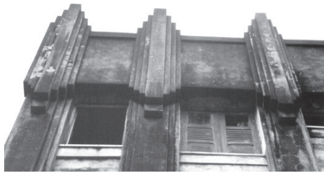
Fig. 4 - Edifício Bomfim, Rua das Vassouras, no 4.
