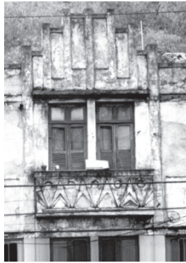
Fig. 23 - Casa à Av. Frederico Pontes, Água de Meninos.
