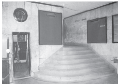
Fig. 27 - Cine Pax, 1939 (hall de entrada).
