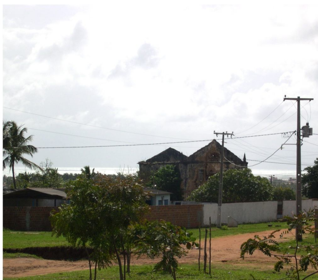
Figura 4.65 Pátio (parcialmente ocupado) e matriz ao fundo.
