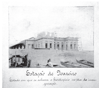
Figura 12 - Estação de Juazeiro, ainda em obras. Fonte: Argollo (1900).
