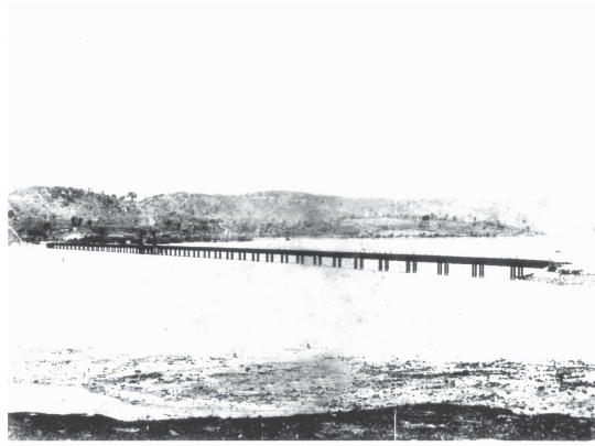
Figura 3- Viaduto de Itapagipe da Bahia and San Francisco Railway, foto de Benjamin Mulock, 1861. Fonte: Arquivo do fotógrafo Valter Lessa.
