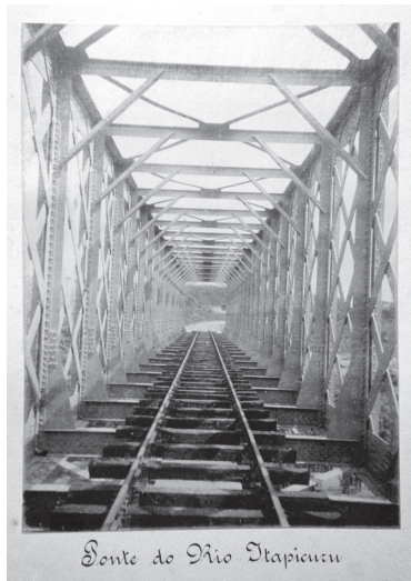
Figura 9- Ponte metálica sobre o rio Itapicuru. Fonte: Argollo (1900).
