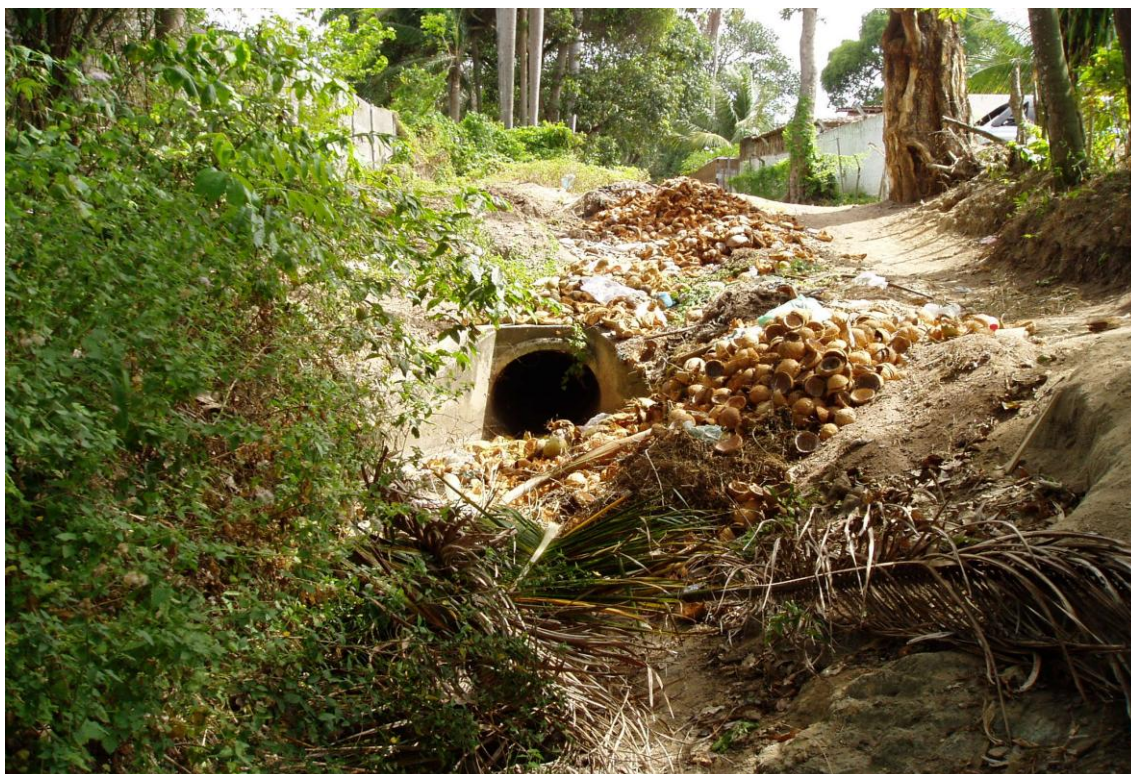
Figura 4.38: Lançamento de galeria pluvial na encosta do vale do rio Marés
