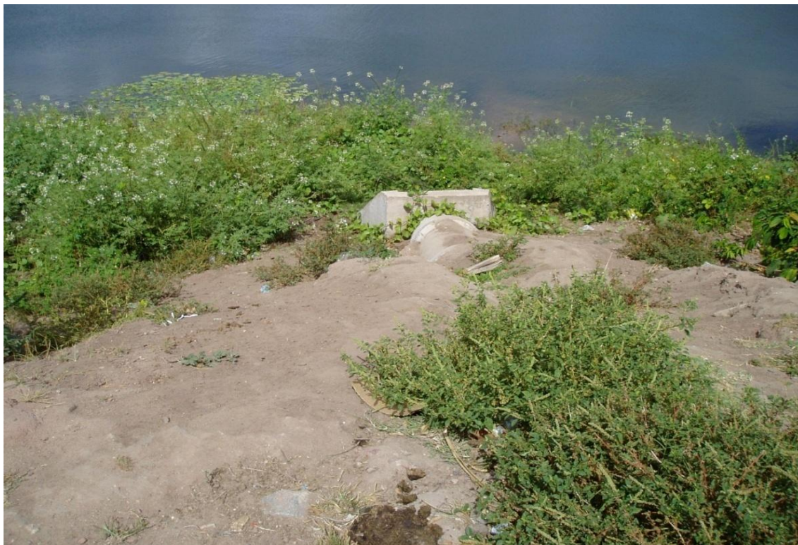
Figura 4.39: Lançamento de galeria pluvial no reservatório do rio Marés
