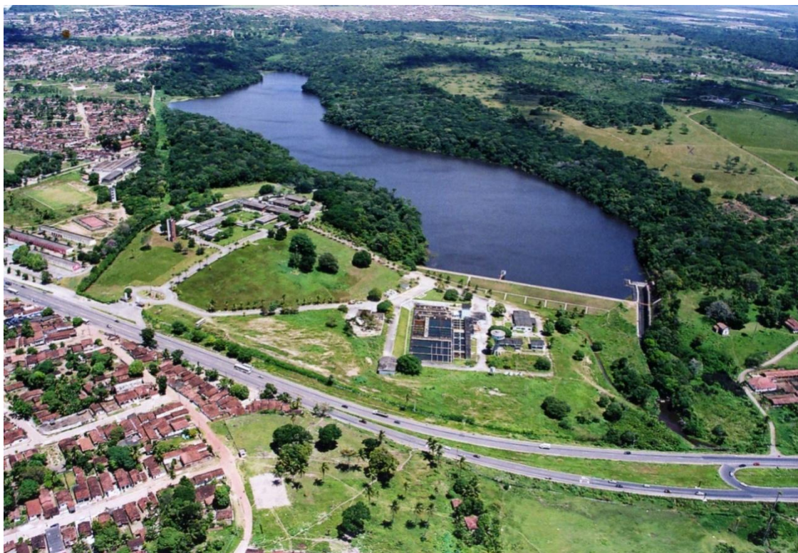
Figura 4.2: Barragem e reservatório de Marés
