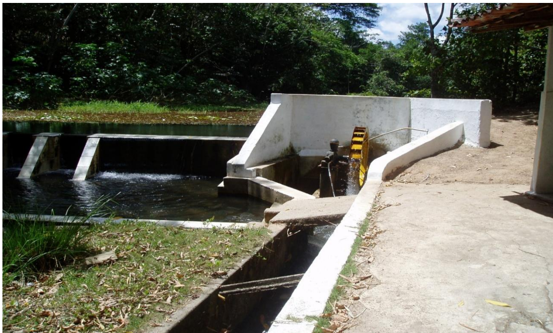
Figura 4.24: Captação particular no rio Marés
