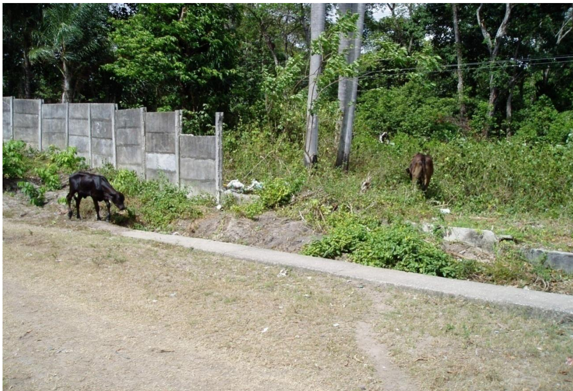
Figura 4.15: Muro de proteção, situação em dezembro de 2010
