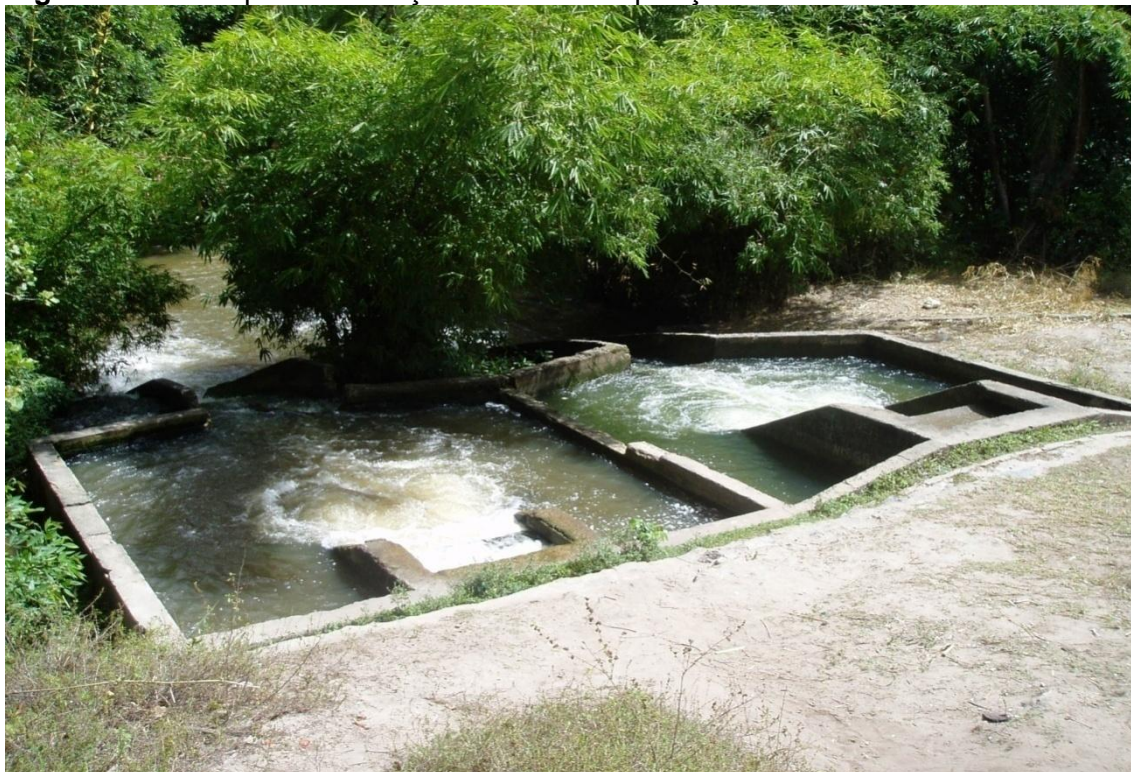
Figura 4.42: Dissipador no lançamento da transposição do rio Mumbaba
