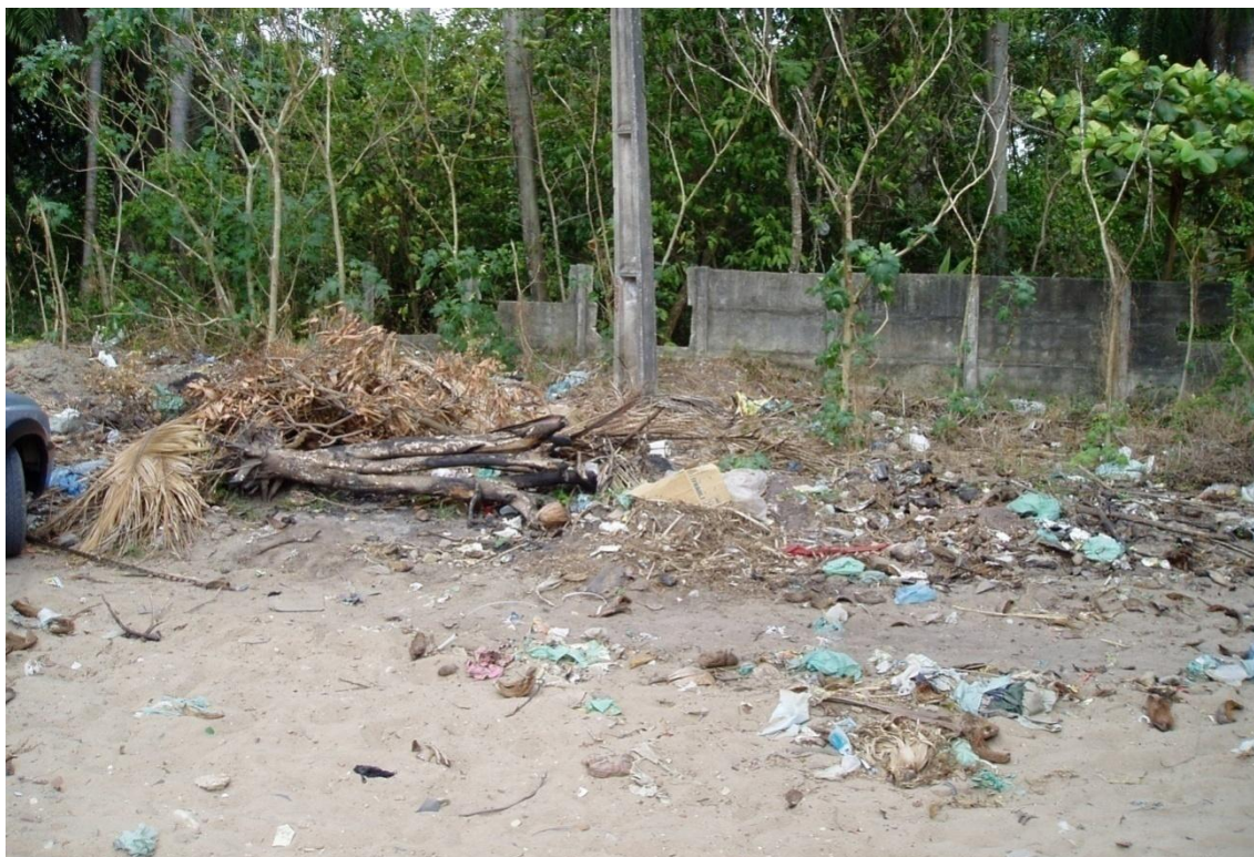
Figura 4.16: Muro de proteção, situação em dezembro de 2010
