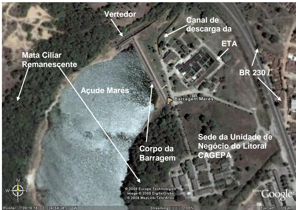
Figura 4.45: Barragem/açude Marés, ETA e sede da Unidade de Negócios do Litoral da CAGEPA
