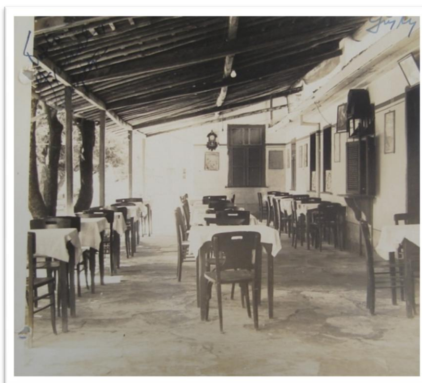
Figura 44 – Vista parcial do refeitório do Colégio Tobias Barreto (prédio II)
