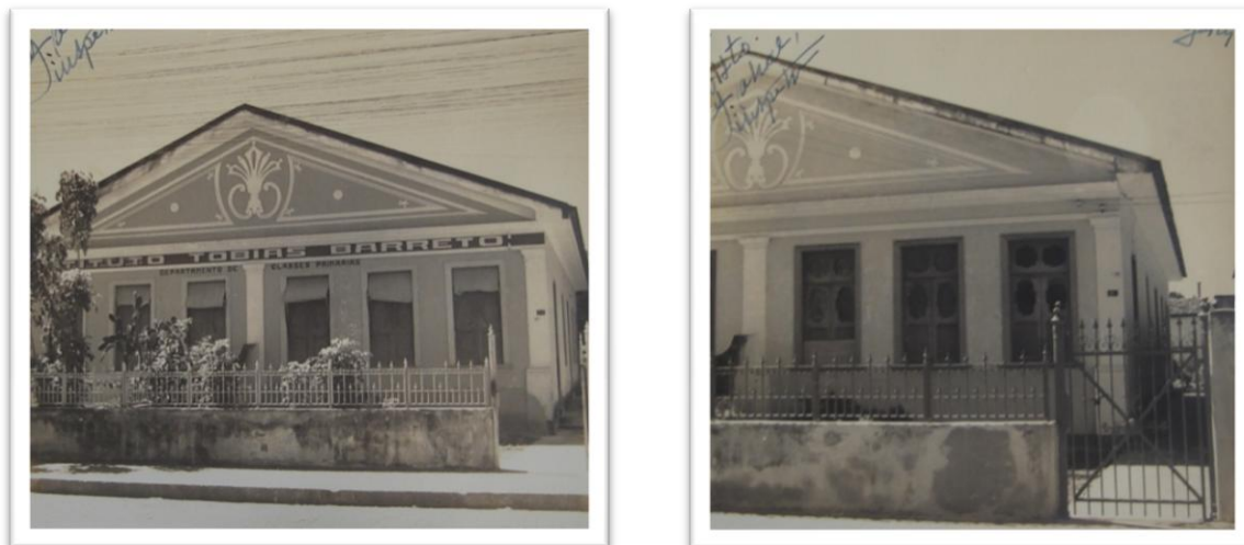
Figura 39 – Prédio III – Colégio Tobias Barreto e Prédio IV – Colégio Tobias Barreto Fonte: Fonte: SANTANA, José Cabral. Relatório para revisão da ficha de classificação do Ginásio Tobias Barreto , 21 de julho de 1943. Aracaju, 1943. DIES – Arquivo de Escolas Extintas.
