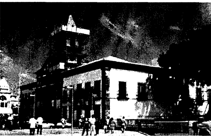
Foto: Márcia Sant'Anna Fig. 6 Projeto Portal da Misericórdia, ação privada desenvolvida com o apoio de incentivos fiscais que tem como pólo ao prédio sede da Santa Casa de Misericórdia na Praça da Sé.
