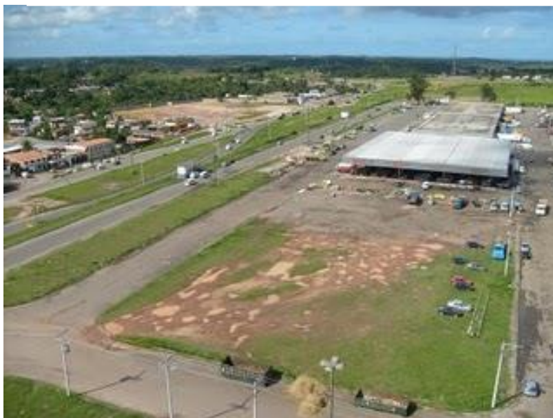
Figura 10: Central de Abastecimento da Bahia
