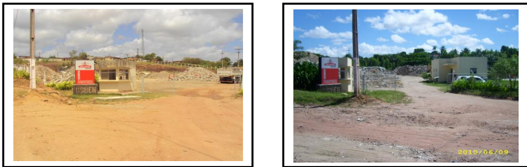
Figura 2.9: USIBEN – Usina de Beneficiamento dos Resíduos de Construção e Demolição de João Pessoa / PB
