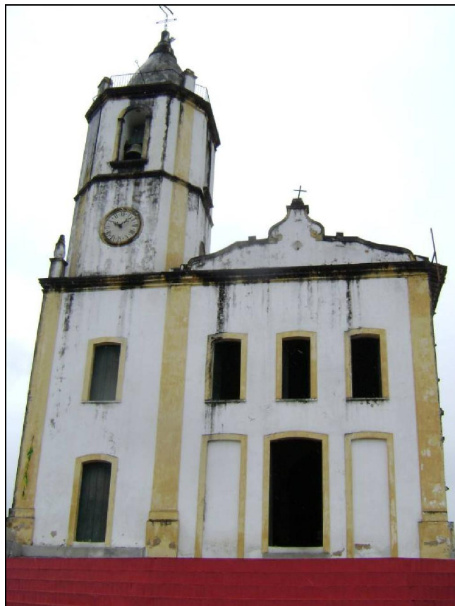
Figura 7: Fachada da igreja do Bonfim Fonte: Roberta Bacellar Orazem, outubro de 2007
