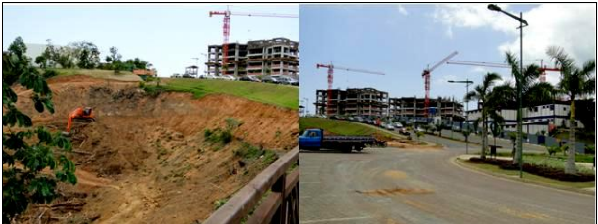
Figura 3. Canteiro de Obras do empreendimento Greenville, Patamares-Salvador – BA, 10/12/ 2011 Fonte: Pesquisa de Tese da autora.
