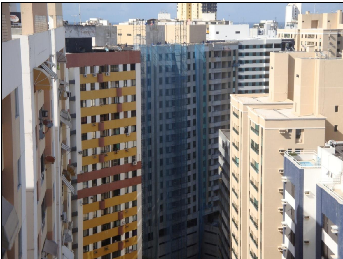
Figura 37. Verticalização e adensamento no Loteamento Vela Branca, Salvador – BA, 10/12/ 2011. Fonte: pesquisa de tese da autora.
