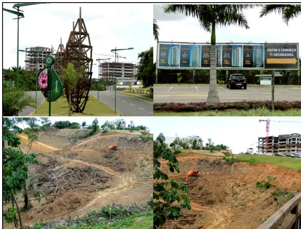
Figura 32. Localidade e canteiro de obras do Greenville, Salvador – BA, 10/12/ 2011.
