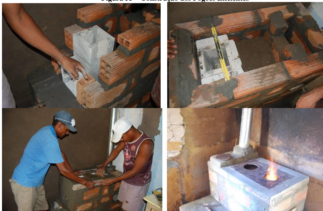
Figura 33 – Construção dos Fogões Eficientes
