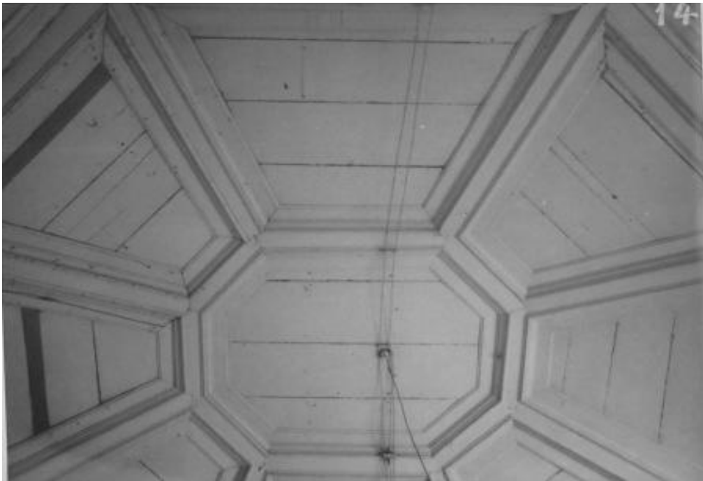
Figura 43 – Forro da Sala do Prior, antes da restauração efetuada pela equipe de Rescala. 1958.
