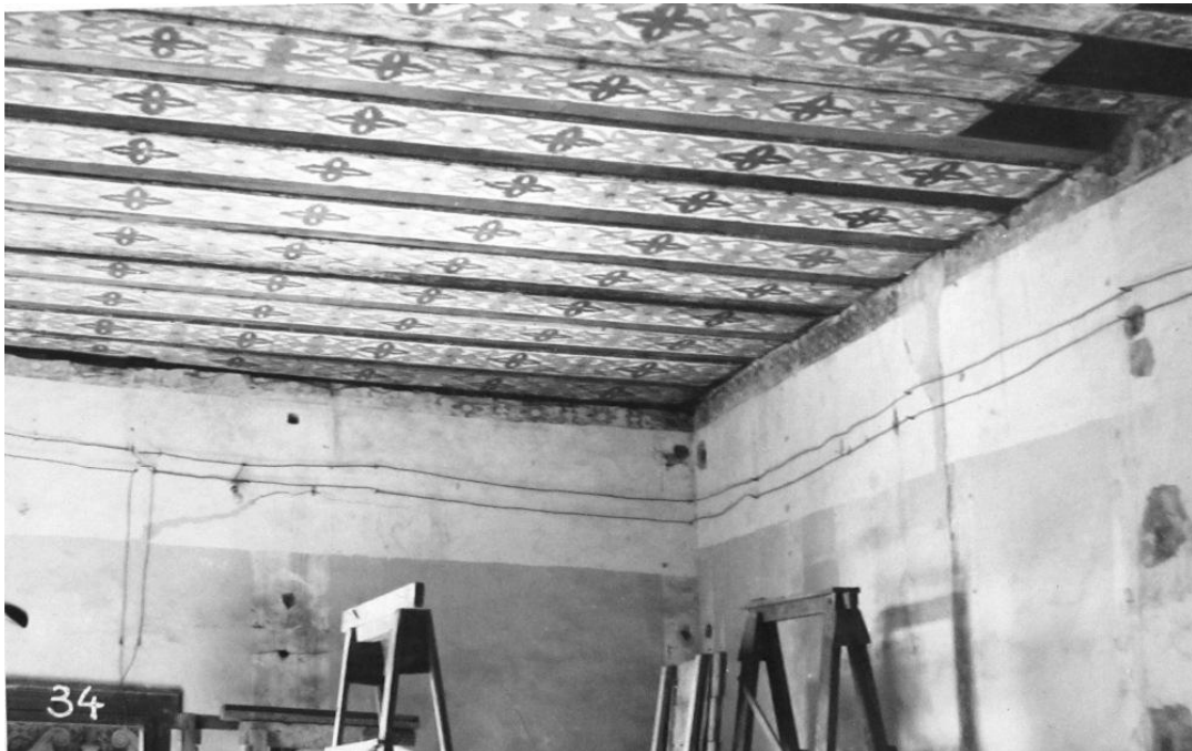
Figura 49 – Forro à têmpera. Sala da Sacristia, 1958.
