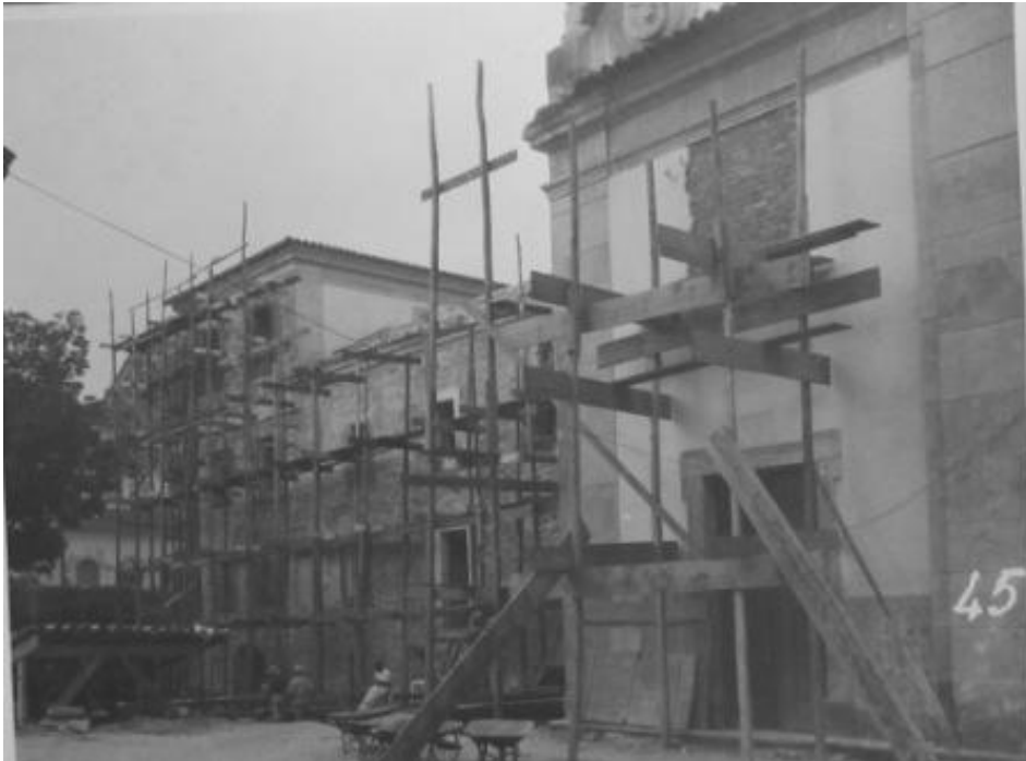
Obras em andamento em 1959. Fonte: Arquivo Histórico do MAS – UFBA.
