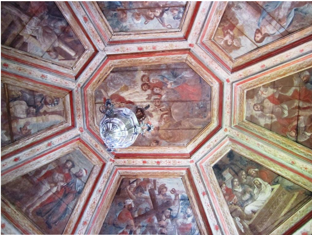
Figura 52- Foto atual do forro da sala do Prior
