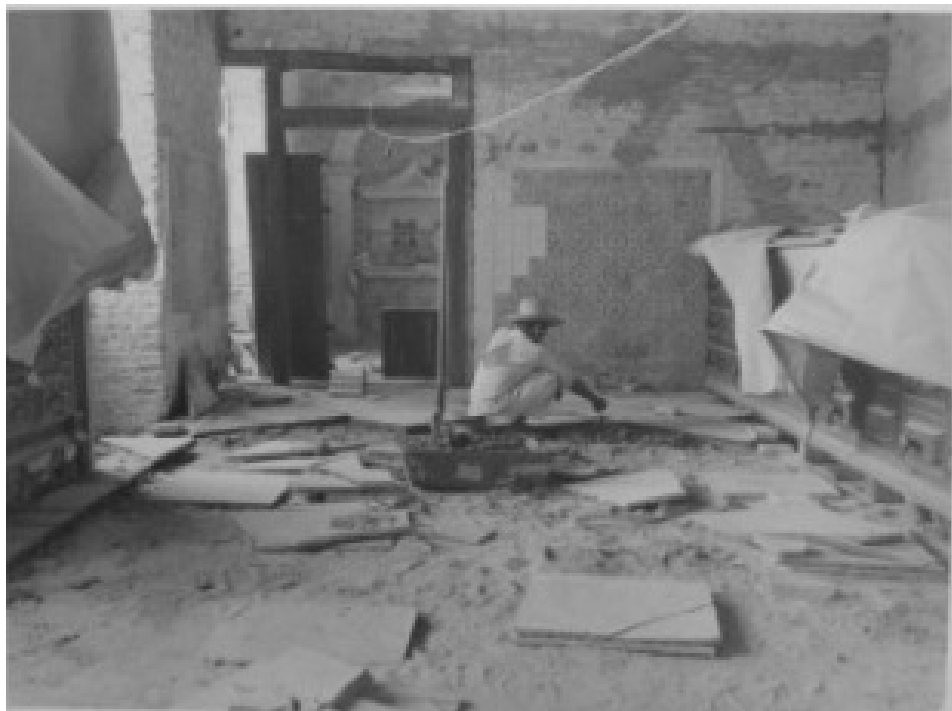
Figura 42 – Assentamento de piso na Sacristia, 1959.
