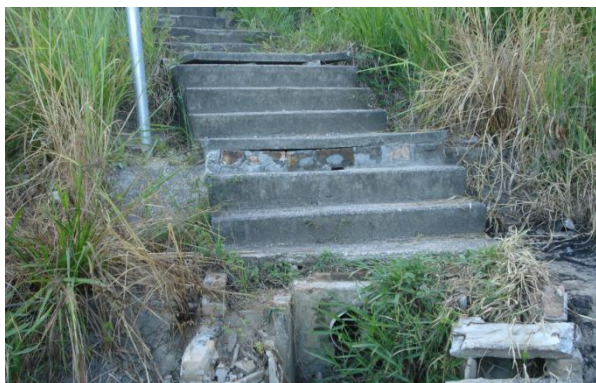
Trecho da Escada do Fundo
