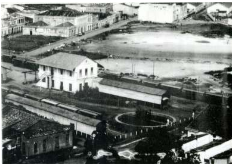
Figura 5 - Vista de cima da Estação de Ilhéus. Fonte: POPOFF, s/d.
