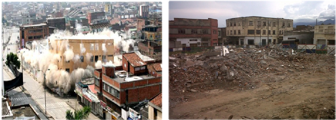
Figura 10. Demolição bairro El Calvário. Cali
