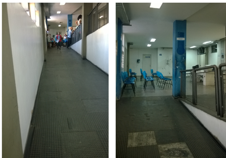
Figuras 45 e 46 - Início e fim da rampa de acesso ao 1º andar e a recepção e área de espera do setor de Neurociências Fonte: arquivo pessoal da autora
