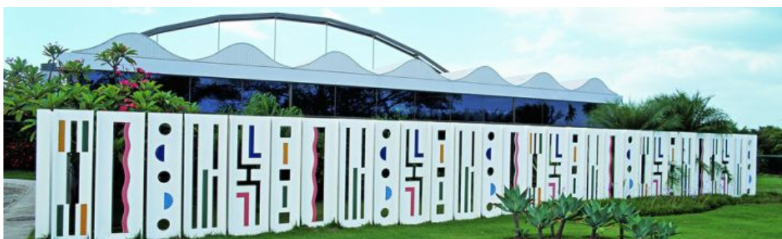
Figura 41 - Muro vazado, argamassa armada, situado na Rede Sarah de Hospitais de Reabilitação de Salvador/BA, 1991 Foto: Tuca Reinés. Fonte: http://www.fundathos.org.br
