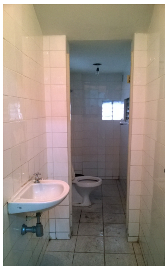
Figura 53 - Vista interna do sanitário feminino do setor de Neurociências Fonte: Arquivo pessoal da autora
