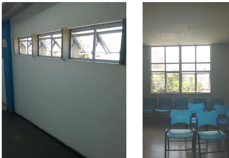
Figuras 55 e 56 - Janelas da rampa e da área de espera do setor de Neurociências Fonte: Arquivo pessoal da autora
