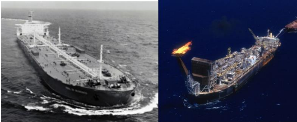
Figura 4.2 – Petroleiro Vidal de Negreiros convertido na FPSO P-31.
