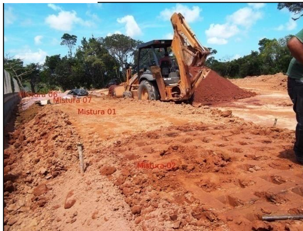
Figura 5. 19: Execução dos aterros experimentais, em série
