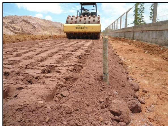
Figura 5. 16: Solo sendo compactação com rolo pé-de-carneiro.
