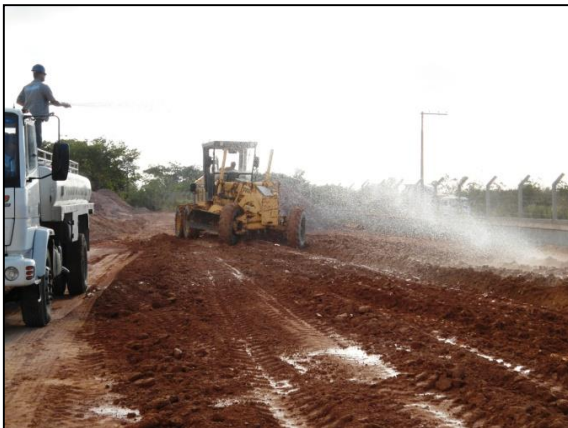
Figura 5. 8: Solo Granulito sendo umedecido.
