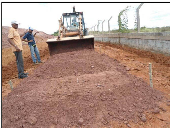
Figura 5. 15: Solo sendo lançado na área demarcada para o aterro
