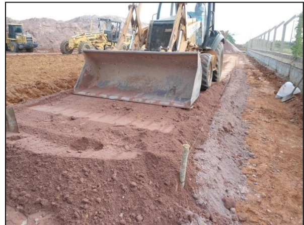
Figura 5. 18: Lançamento da próxima camada de solo após a provação do controle de compactação.
