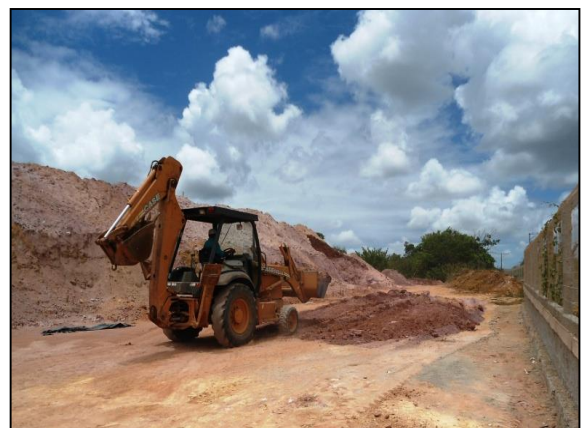
Figura 5. 7: Solo Barreiras sendo homogeneizado
