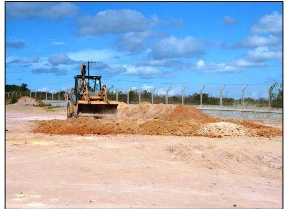
Figura 5. 6: Solo Granulito sendo homogeneizado.
