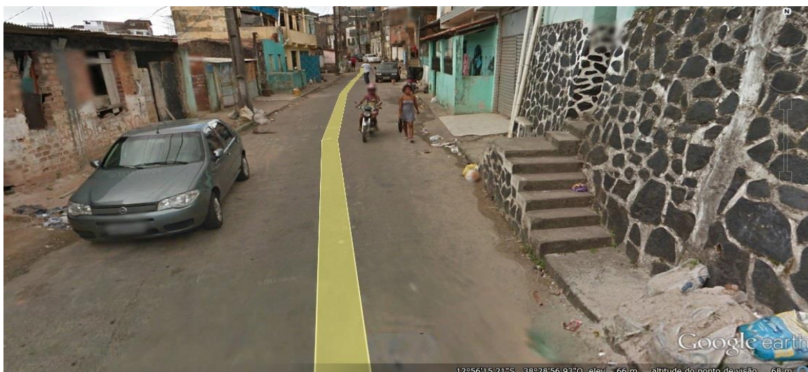
Figura 41. Rua Pacheco de Oliveira (Trecho 3), bairro de Fazenda Grande do Retiro, Salvador, Bahia.
