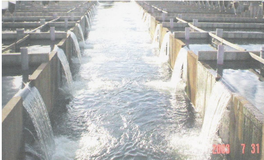
FIGURA 01 – BATERIAS DE RACEWAYS FONTE: Oliveira, 2003
