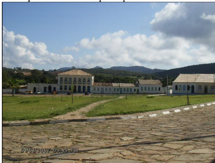
Ilustração 33. Prédios do poder público de Rio de Contas.
