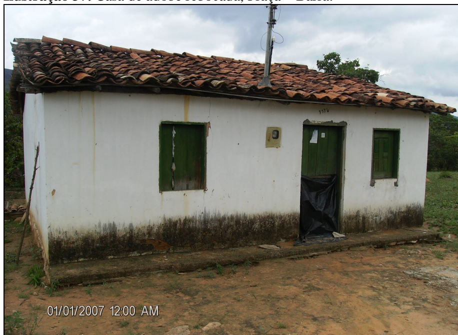
Ilustração 37. Casa de adobe rebocada, Praça – Barra.
