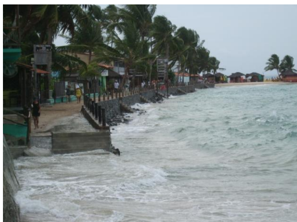
Figura 40: Maré avançando sobre as construções da 3ª praia Fonte: Pesquisa de Campo, 2009-2010
