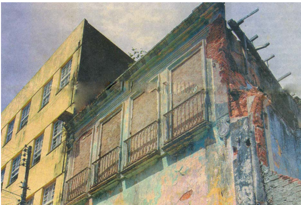
Figura 10 - Imóveis da 7ª etapa vão virar moradias.
