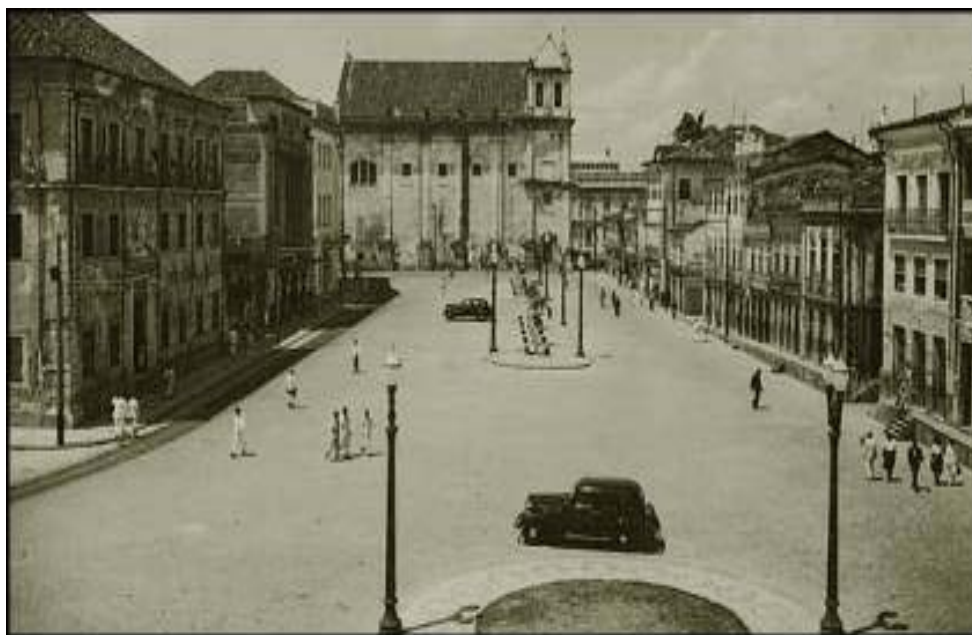
Figura 6 - Praça da Sé, primeira versão depois de demolida a Igreja. Fonte: Fundação Gregório de Matos, 2007.
