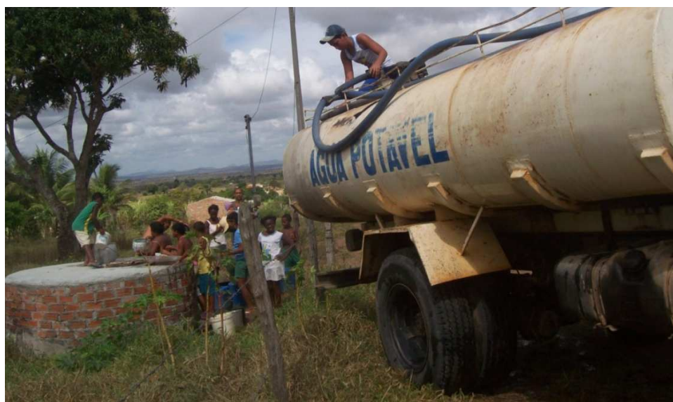
Fig. 20 (Des)Abastecimento do reservatório
