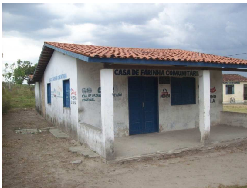
Fig. 25 Prédio da casa de farinha na comunidade de Olaria
