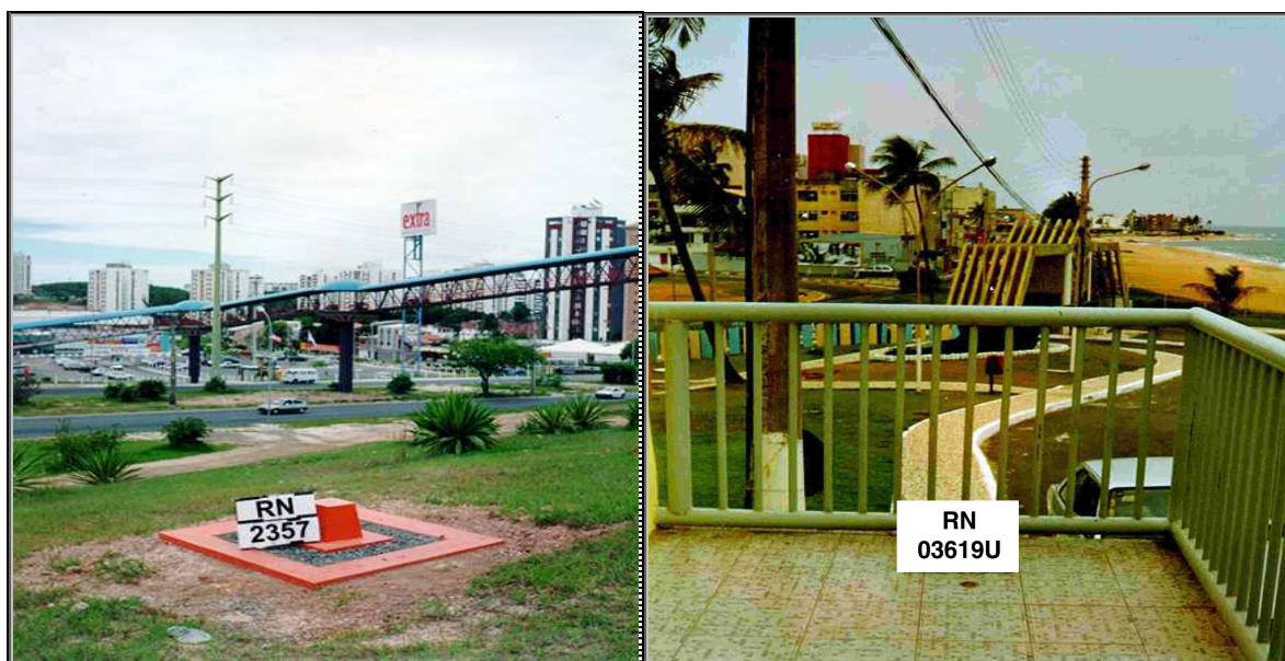
Foto 1 - Formas de Materialização dos Marcos Geodésicos
