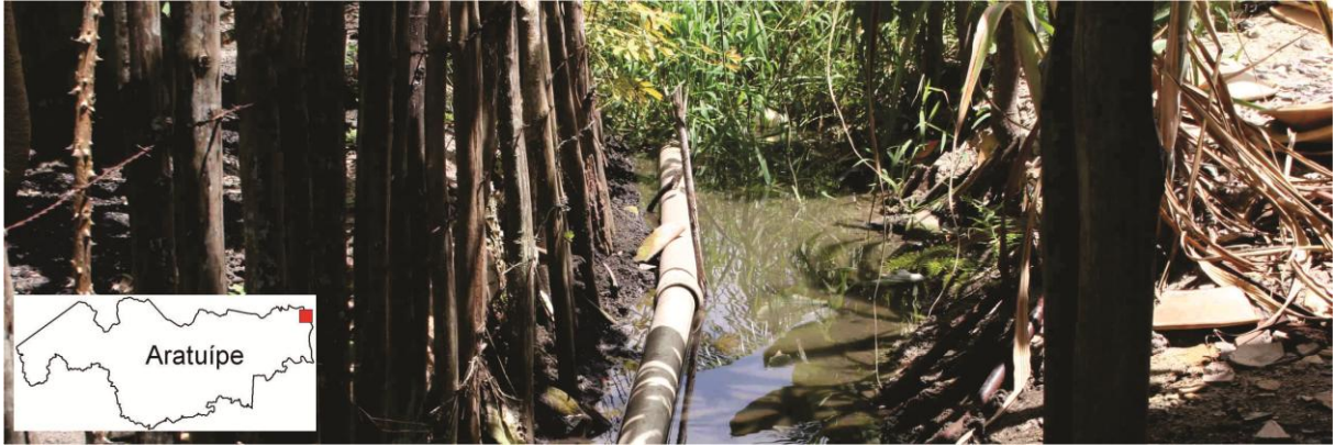
Figura 47: Tubulação lançada no manguezal, município de Aratuípe, BA.
