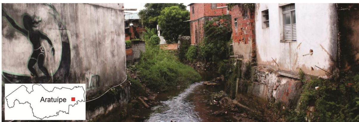
Figura 33: Tubulações das casas direcionadas ao Rio Aratuípe, município de Rio Aratuípe, BA. Foto: Ed. Avelino, 2012.
