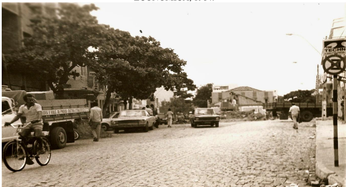
Figura 40 - DEMOLIÇÃO DO CENTRO COMERCIAL DA CIFERG E CAIXA ECONÔMICA, 1984.
