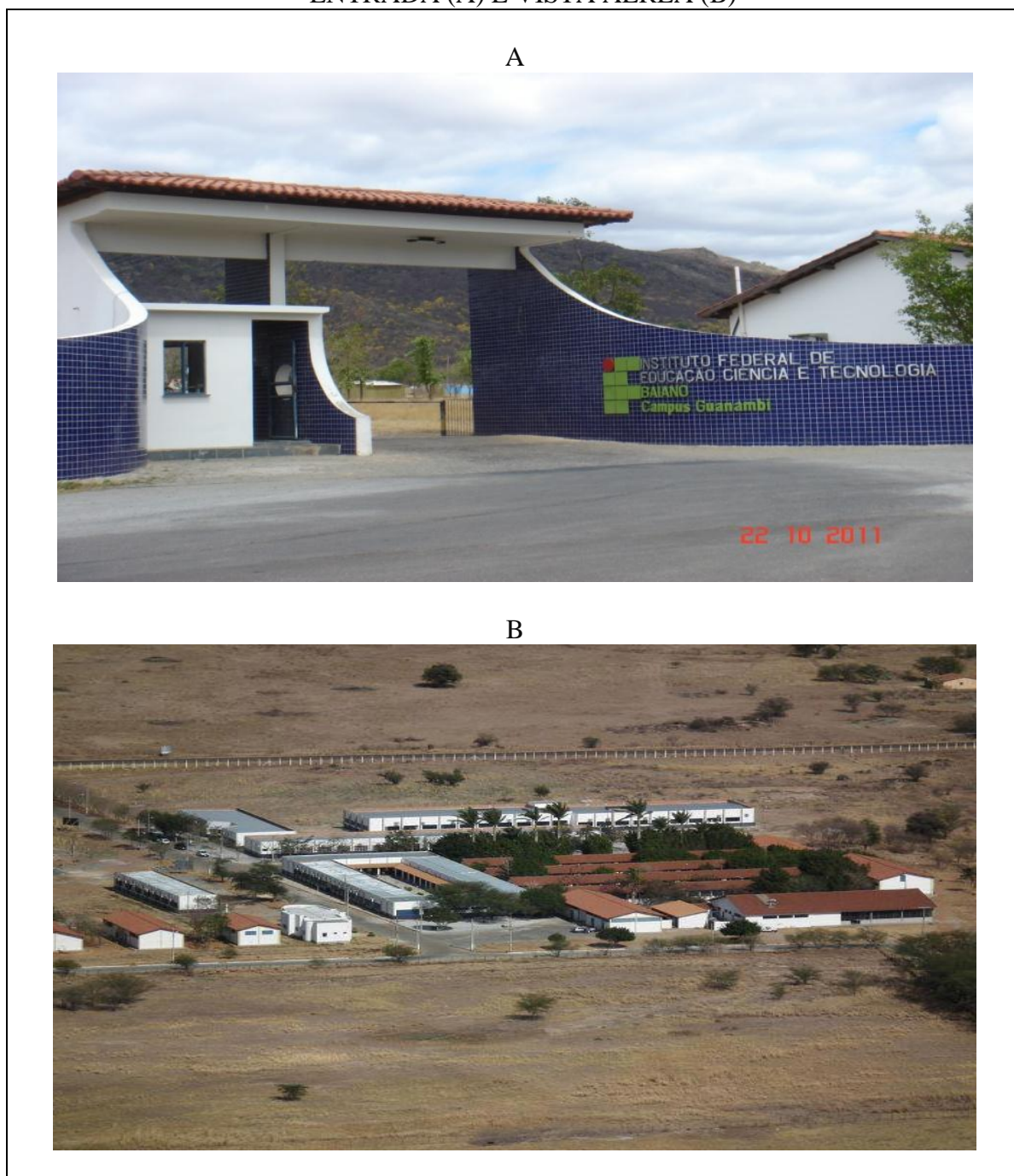
Figura 16 - IFBAIANO CAMPUS GUANAMBI: ENTRADA (A) E VISTA AÉREA (B)
