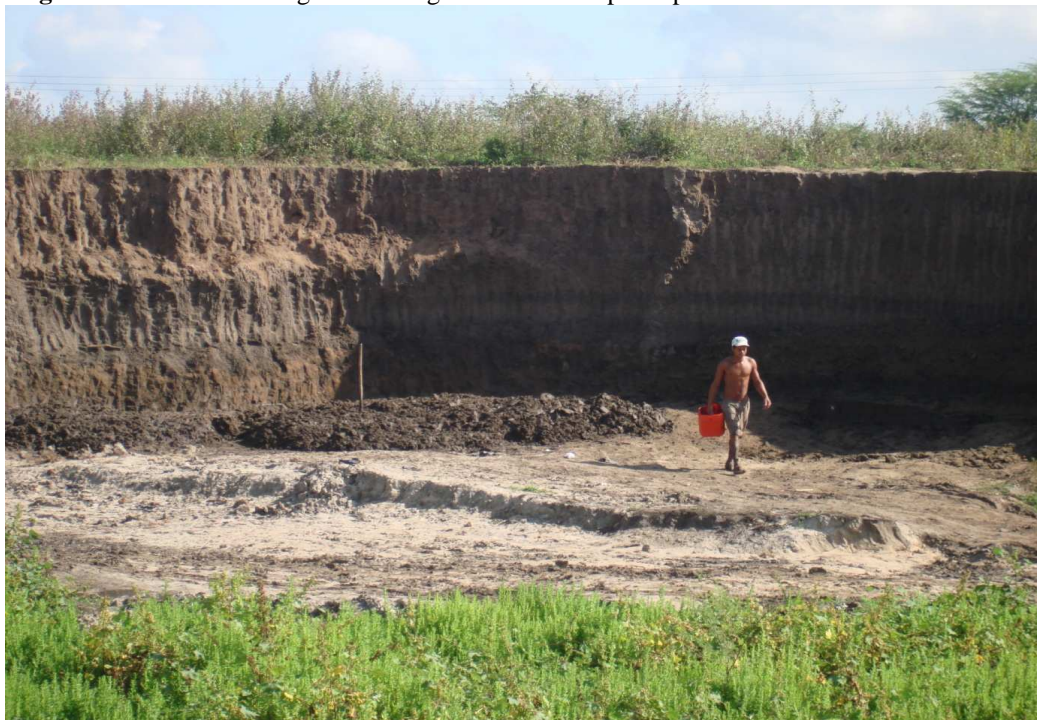
Figura 43 - Retirada de argila nas margens do rio Jacuípe no perímetro urbano
