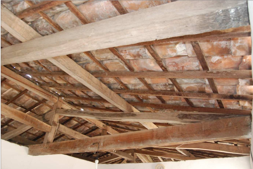
Figura 25 - Construção da década de 60 com madeira retirada da caatinga local
