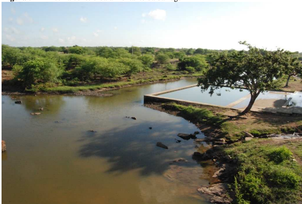
Figura 572 - Piscina construída à montante da barragem
