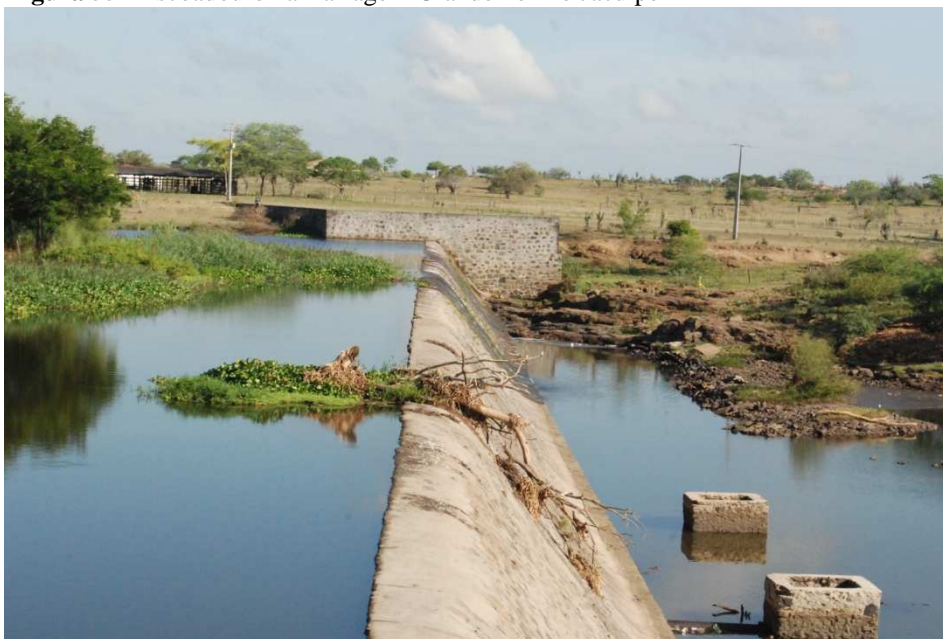
Figura 55 - Escoadouro na Barragem Grande no Rio Jacuípe
