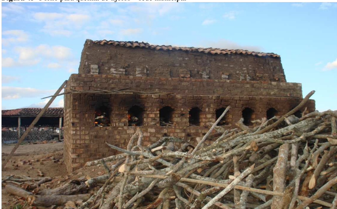
Figura 45- Forno para queima de tijolos – sede municipal
