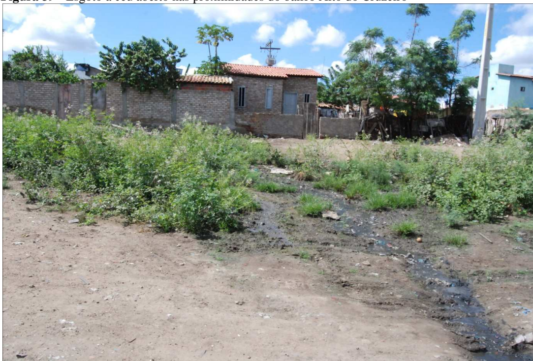
Figura 39 - Esgoto a céu aberto nas proximidades do bairro Alto do Cruzeiro
