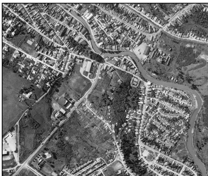
Figura 10: Foto Aérea - Trecho do Subaé na Área Urbana de Santo Amaro
