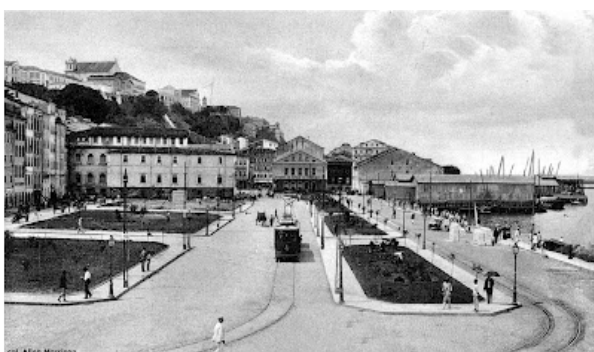
Figura 14. Praça Marechal Deodoro
