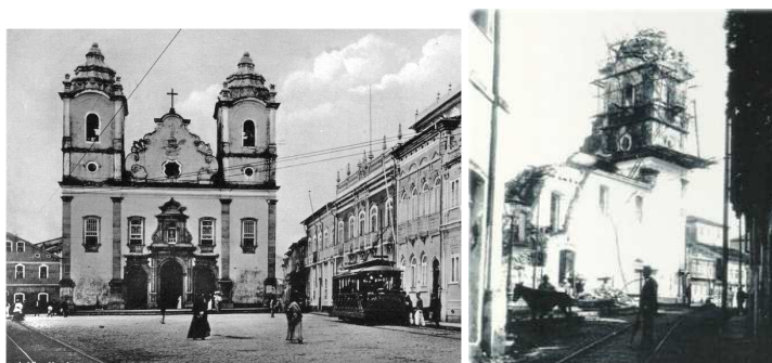
Figura 6. Demolição da Igreja de São Pedro
