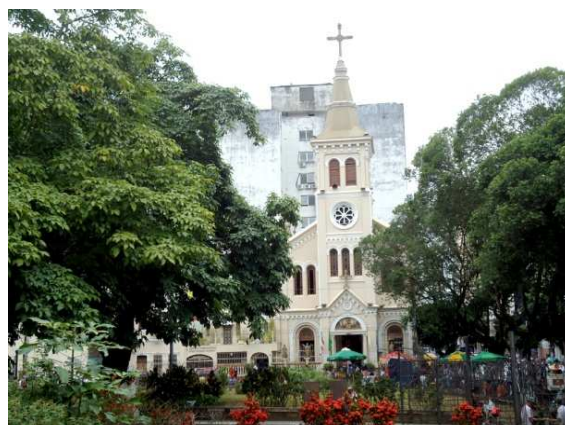
Figura 48. Igreja de São Pedro que substituiu a que foi demolida. Fonte: Acervo da Autora Maio 2013.
