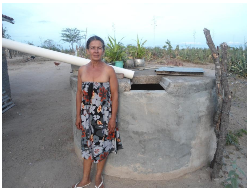
Figura 12: Cisterna com captação de água
