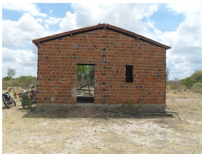
Figura 29: Sede em construção da Associação de Cassatinga. Fonte: Trabalho de Campo, Outubro de 2012.
