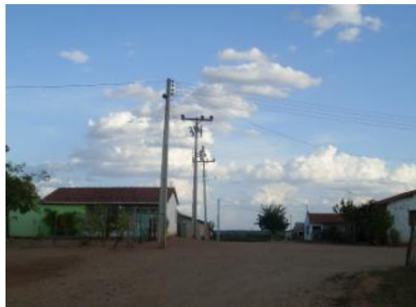
Figura 7: Postes de Energia Elétrica
