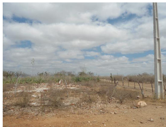
Figura 14: Ruínas de prédio escolar
