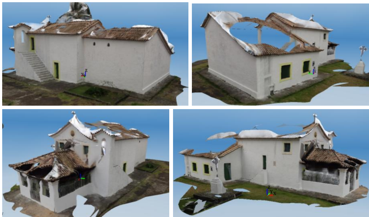
Figura 167 - Diversos ângulos da malha TIN da capela gerada no 123D Catch
