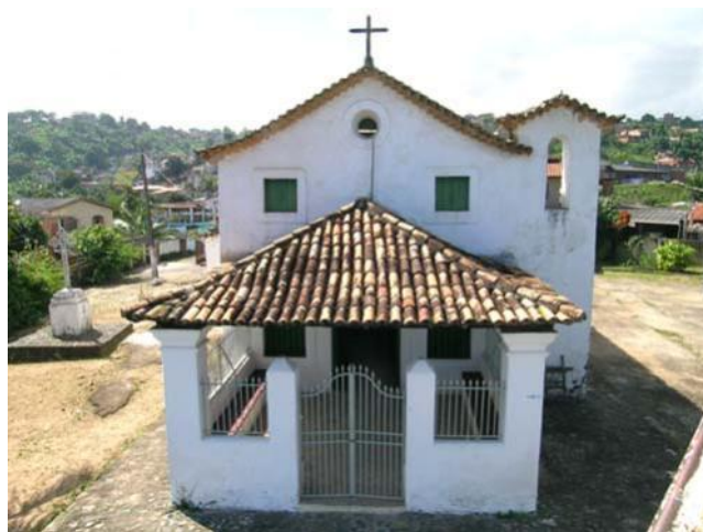
Figura 156 - Fotografia da fachada principal da Capela de Nossa Senhora da Escada
