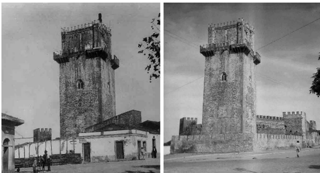
Figuras 09 e 10: Castelo de Beja antes e depois da intervenção da DGEMN. Fonte: Espólio da DGEMN, Arquivos o IHRU
