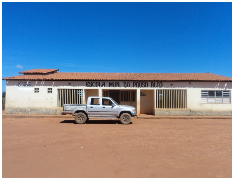
Figura 15 - Escola Municipal Cristovão Colombo
