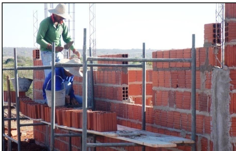
Foto 19 - Agricultores familiares trabalhando na construção de residências no campo. Comunidade rural de Bucho da Nega no município de São Gabriel. Fonte: Organizado por OLIVEIRA, E. F. Foto tirada na pesquisa de campo - Out. 2015
