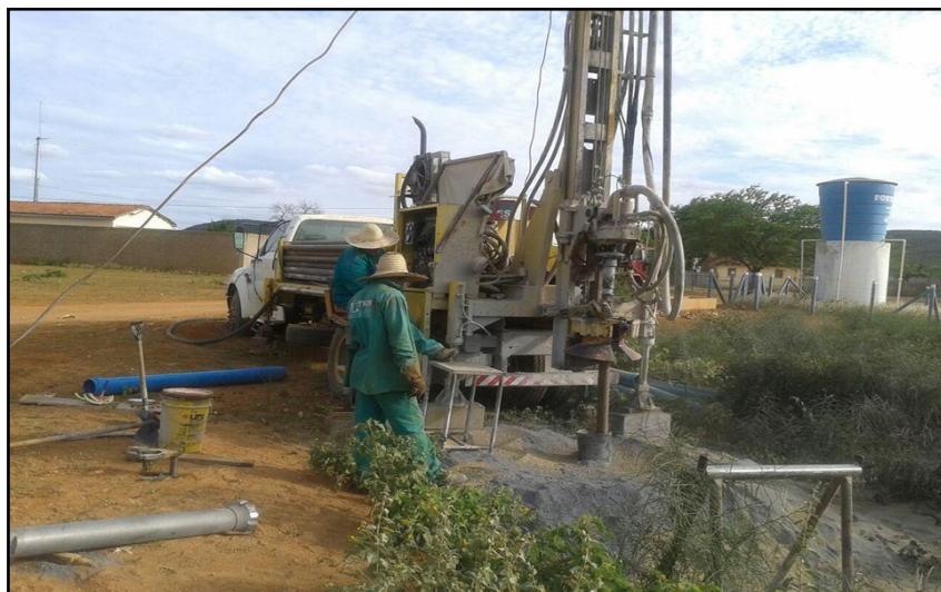
Foto 2 - Perfuração de poço artesiano no povoado de Itapicuru no município de São Gabriel. Fonte: OLIVEIRA, E. F. Foto tirada na pesquisa de campo - Fev. 2015
