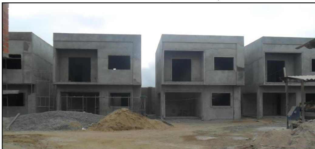
Figuras 16 Condomínio Morada das Flores (em construção) - 2013
