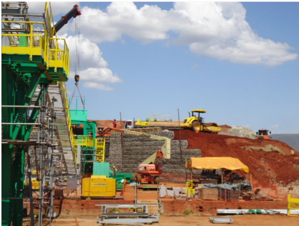
Figura 2 Britador da usina de beneficiamento mineral em fase de implantação - 2013
