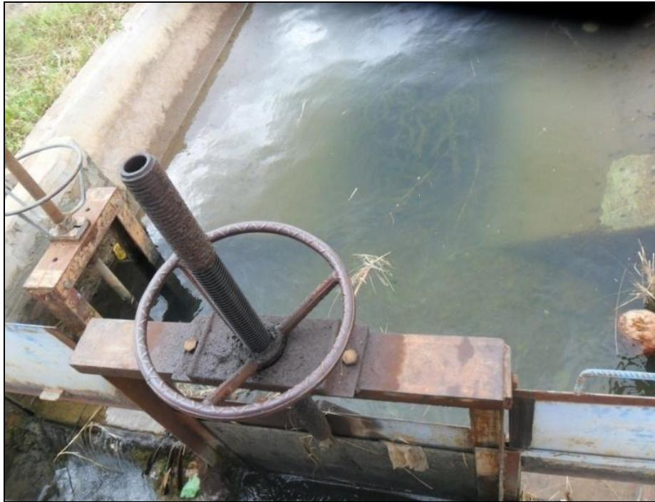
Figura 13. Comporta que controla o fluxo de água para o canal principal de irrigação do Perímetro Mandacaru, direção L-W
