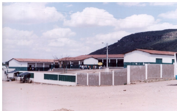
Foto 43 – Santa Brígida – Colégio Estadual
